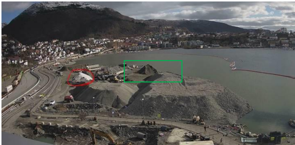
Figur 4. Bilde fra Store Lungegårdsvann, som viser lagring på prosjektets område av ca. 1500 m 3 lettere forurensede jordmasser (markert med rød sirkel), 10.000 Am 3 sprengstein som er fylt ut i sjø fra kote -4 til kote 0 (markert med grønn firkant).
