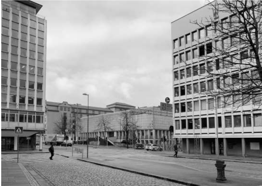
Eksisterende bygning. Illustrasjon: HLM arkitektur
