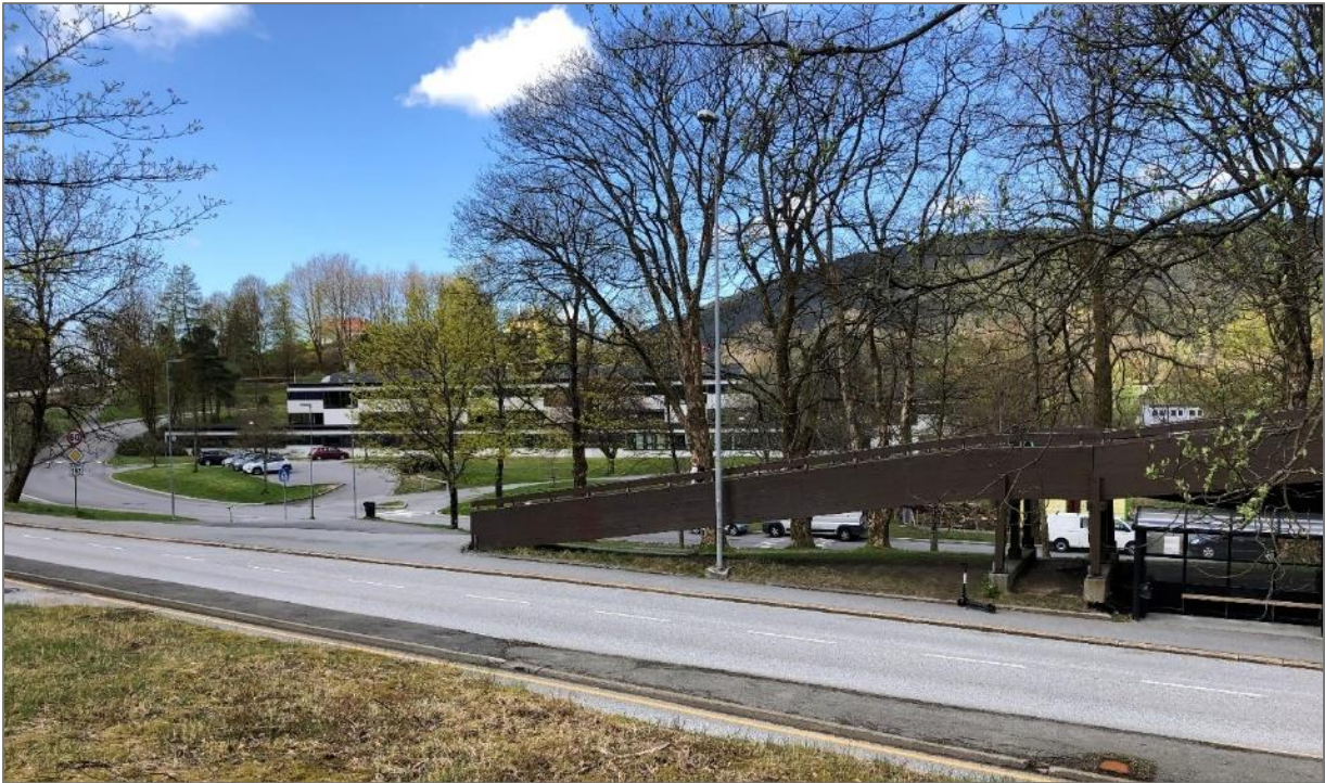
Figur 3.4.2. Limtrebroen over Storetveitvegen. Skolen i bakgrunnen
