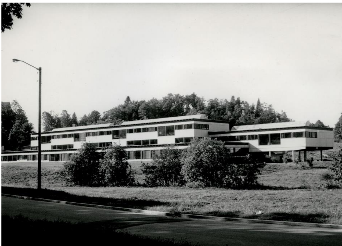
Figur 3.4.1: Storetveit skole ble oppført i 1967, og har svært høy arkitekturhistorisk verdi (foto fra Bergen Byarkiv)
