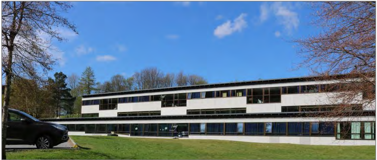
Figur 23. Fasade U-blokken sett fra øst
