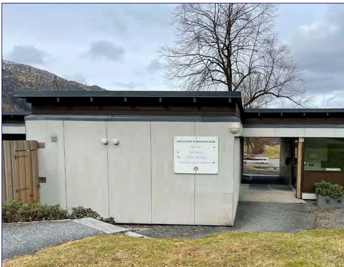
Figur 30. Fasade A-blokken, sett fra sør-vest. Her ser man vaktmesterboligen som i dag blir brukt til kontorer. Bildet viser også smettet i bygget som gjør det mulig å bevege seg fra parkeringsområdene og inn i skolegården.
