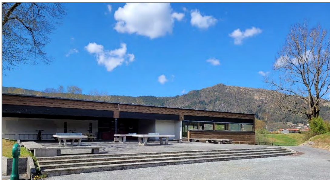
Figur 34. K-blokken sett fra øst. Limtre-fasaden med langsgående treverk og de horisontale vindusbåndene understreker horisontaliteten.
