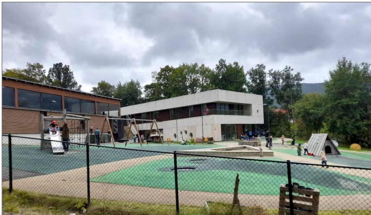
Figur 56. Storetveit barnehage, sett fra øst
