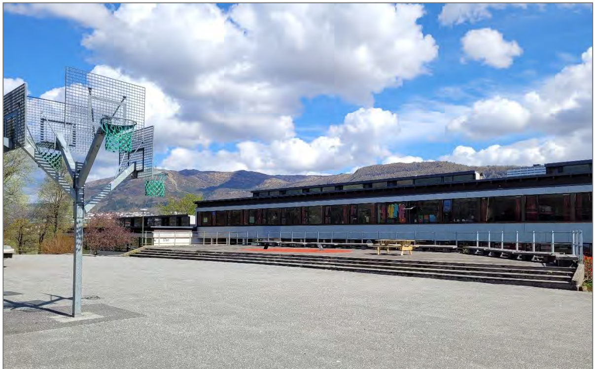
Figur 25. Fasade U-bygg, sett fra skolegården
