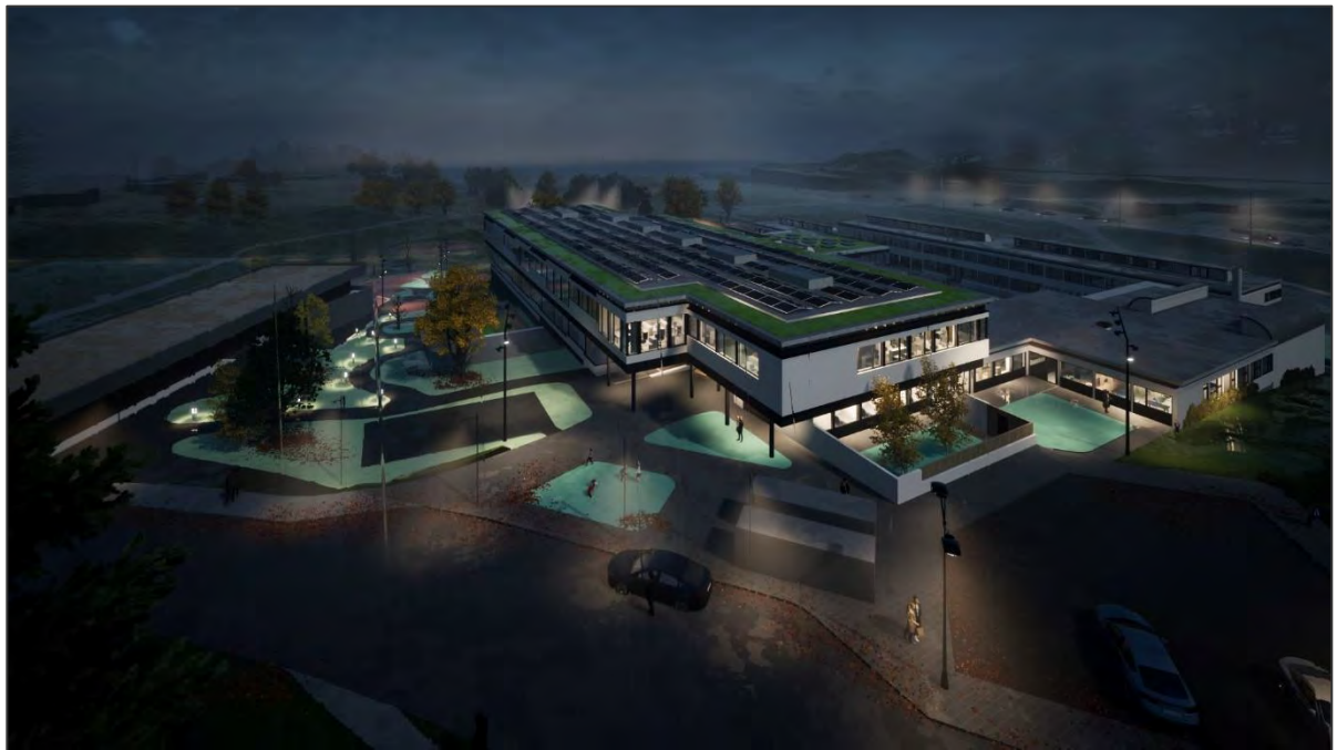
Figur 97. Skolen med foreslått belysning, sett fra sør-vest og Storetveitvegen 127
