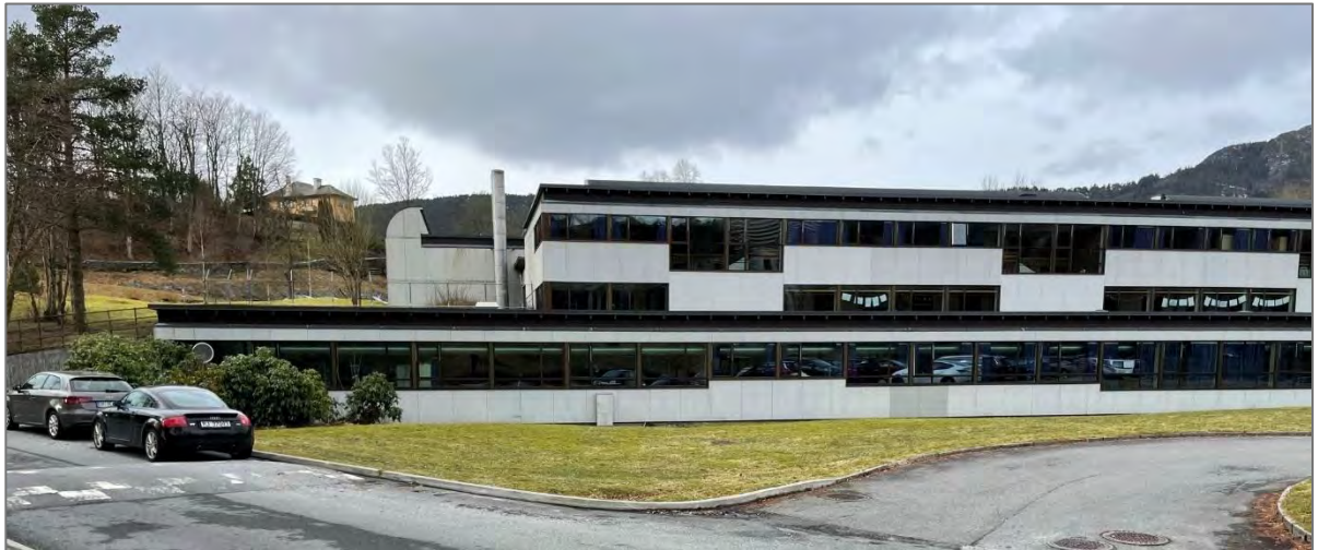
Figur 24. Fasade U-blokken sett fra øst
