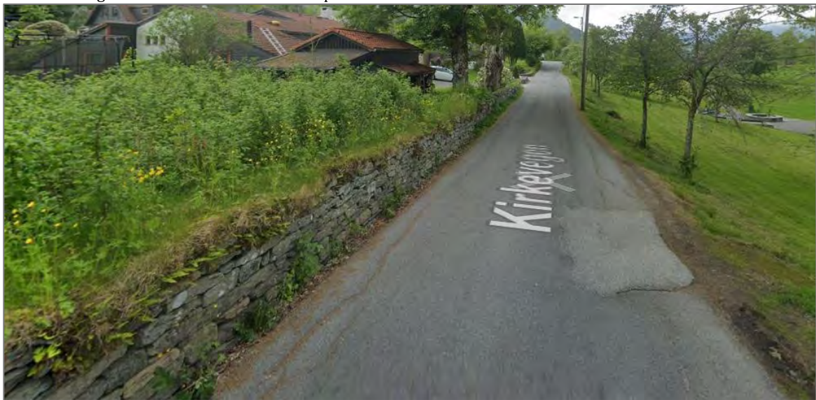
Figur 90. Steingjerde langs kirkevegen (Google, 2022)
