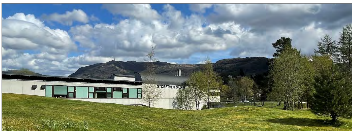
Figur 28. Fasade A-blokken, sett fra sør-vest. Her ser man særlig hvor godt terrengtilpasset skolen er.
