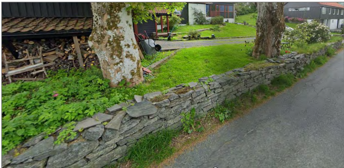
Figur 91. Steingjerde langs kirkevegen (Google, 2022)
