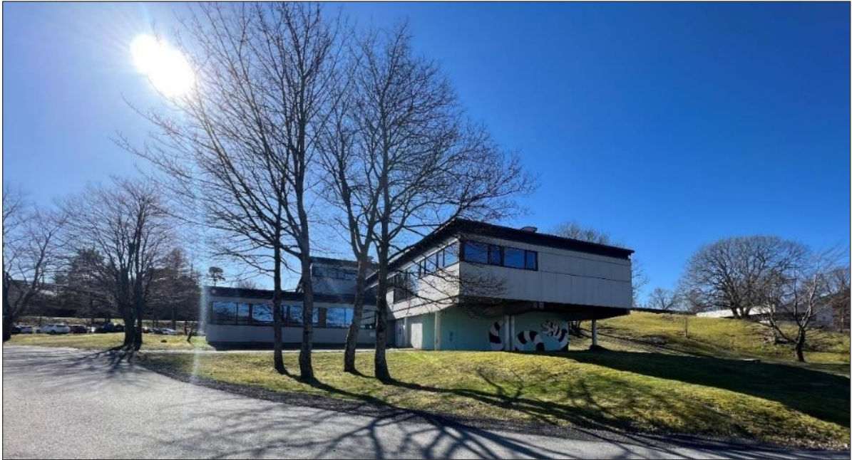
Figur 25. Skolebygg sett fra nord-øst
