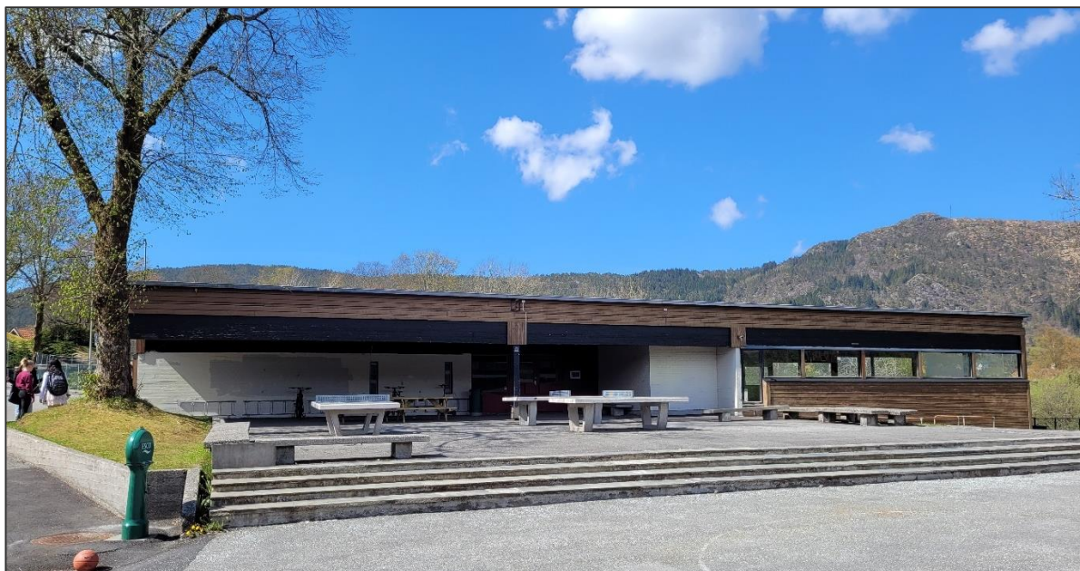
Figur 24. K-blokken, sett fra øst (Rambøll, 2021).
