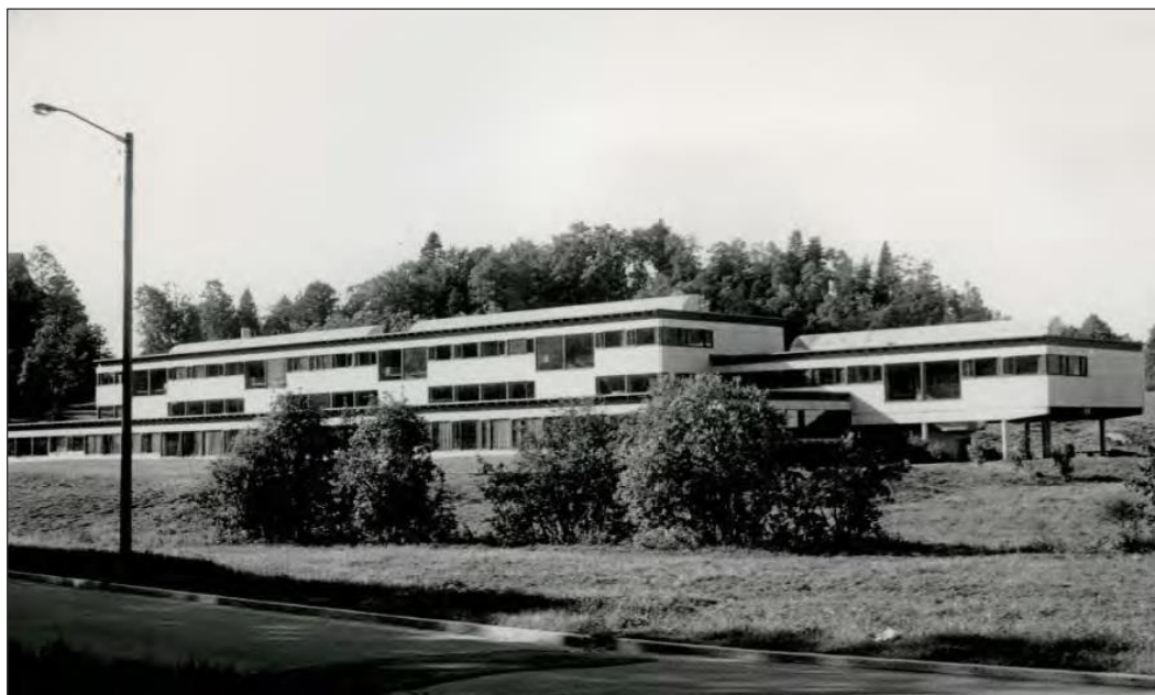
Figur 22. Stortveit ungdomsskole ble bygd i 1967 som realskole før ungdomsskolen ble innført i 1970. Skolen ble tegnet av arkitekt Helge Borgen. Fotograf: Øyvind H. Berger. Fotoregristrering av Bergen, Bergen Byarkiv (Krzywinski & Nilsen , 2014)
