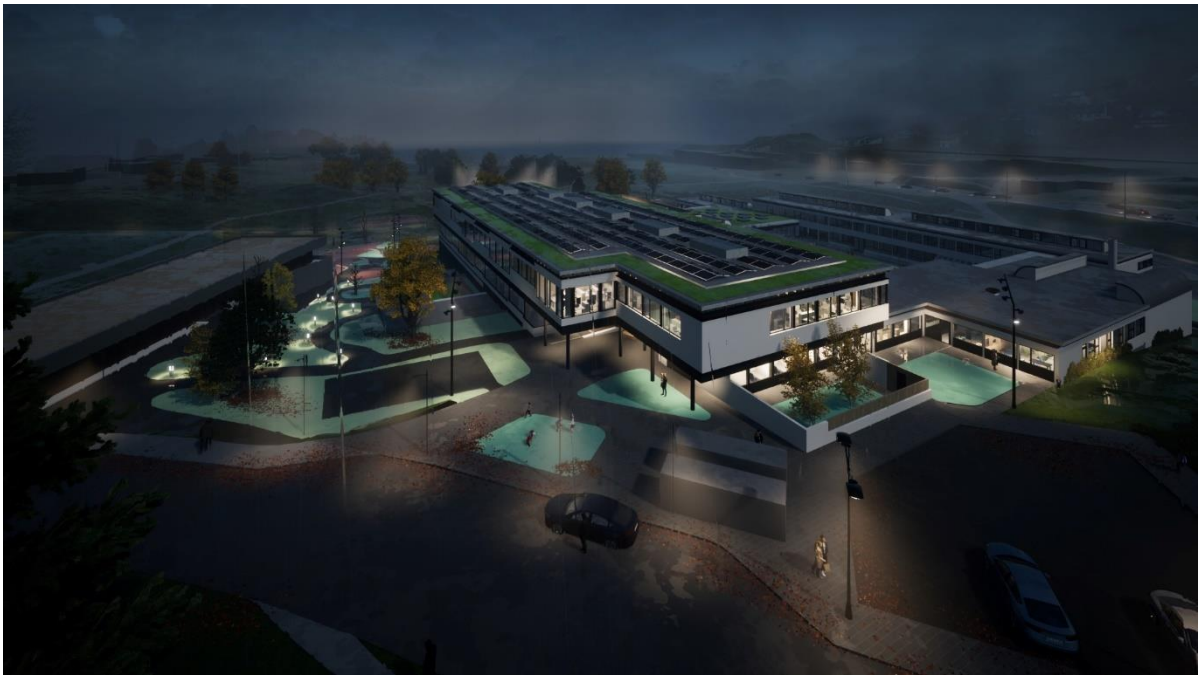
Figur 9. Skolen med foreslått belysning, sett fra sør-vest og Storetveitvegen 127
