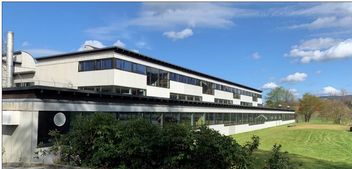
Figur 23. Fasade U-blokk, sett fra sør-øst
