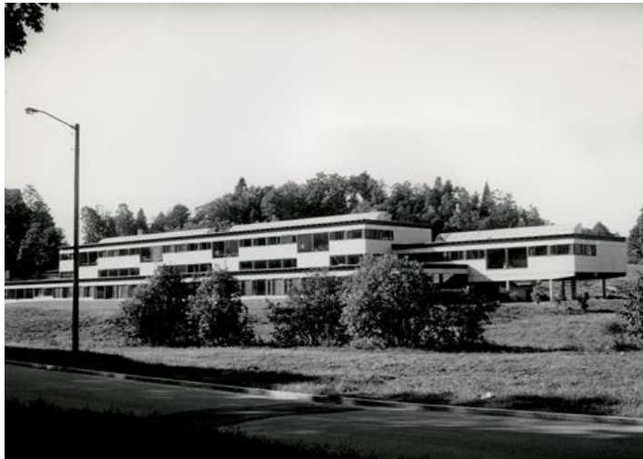
Figur 4.3: Storetveit skole (Kilde: Byantikvaren, 2014).
