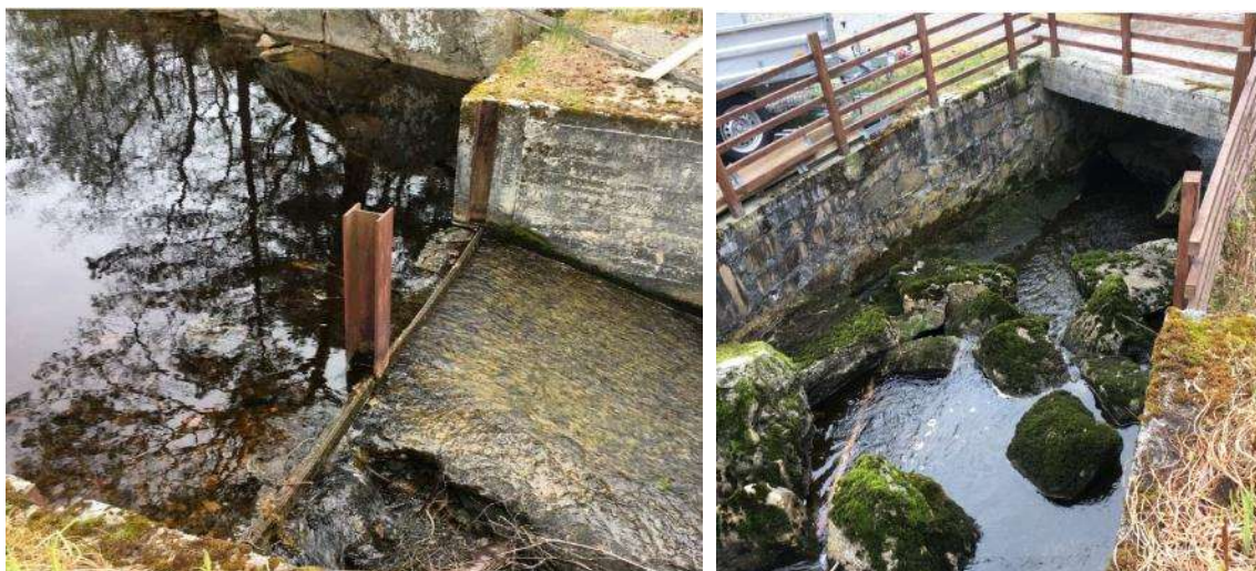
Figur 17 Bilde til venstre viser vandringshinder for fisk mellom Gjeddevatnet og Bjørndalsvatnet. Bilde til høyre viser også øvre del av bekken med bro som gir tilkomst til Bjørgeveien 251. Bildene er tatt på lav vannføring.
