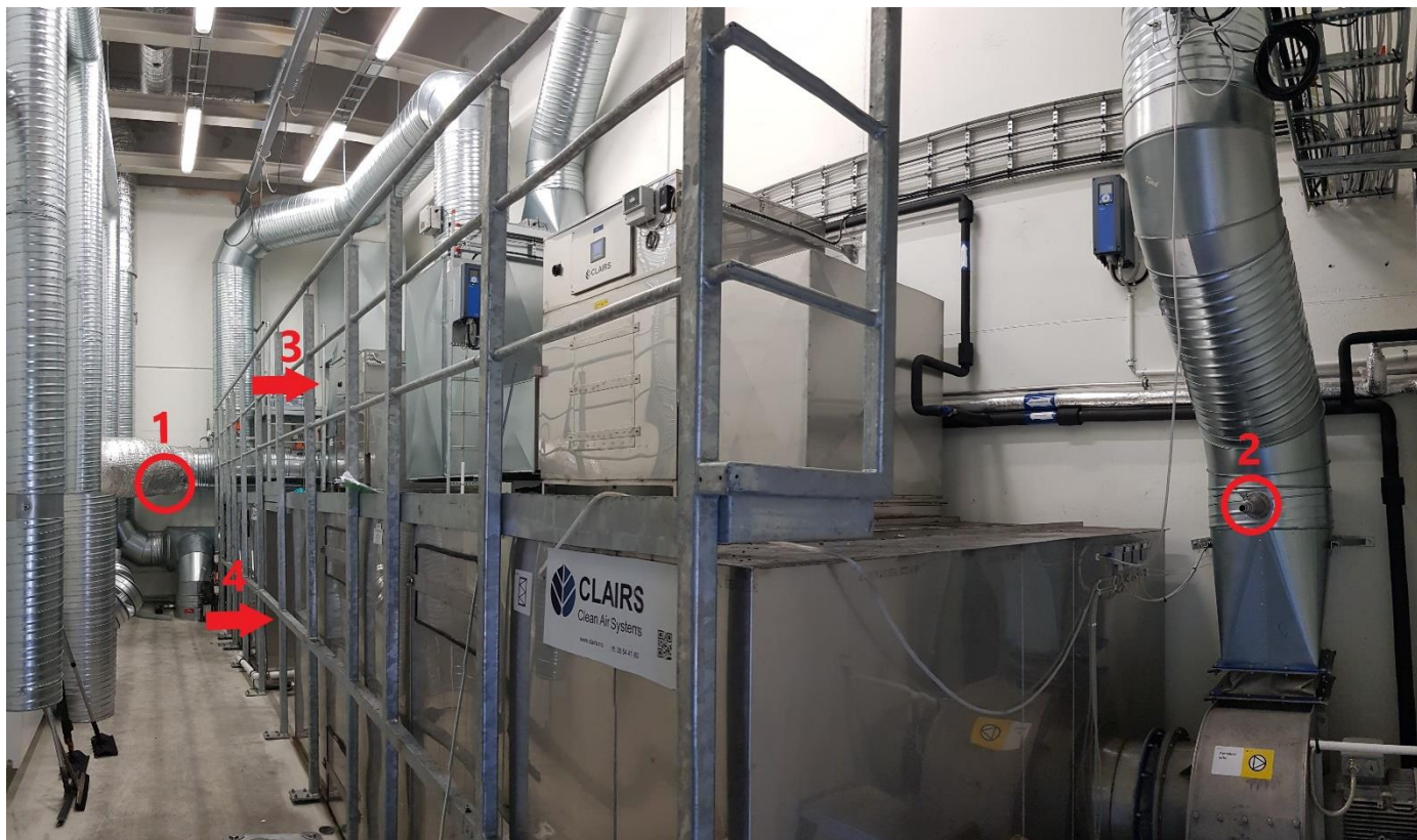
Figur 1. Prøvepunkter slam før og etter kullfilter (hhv. 1 og 2), og prosess før og etter kullfilter (hhv. 3 og 4).
