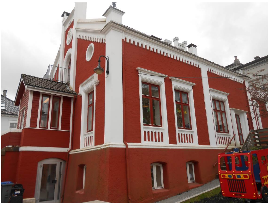
Figur 10: Bygningens nordvestfasade, Døren helt til høyre i bildet var opprinnelig kjøkkeninngang, og her var det i 1880 også et tilbygg for toalett. Dette er forklaringen på at dørens øvre avslutning i fasaden er lavere enn vinduene. Trappen opp til døren er også fra denne tiden (Foto: Byantikvaren 2015).
