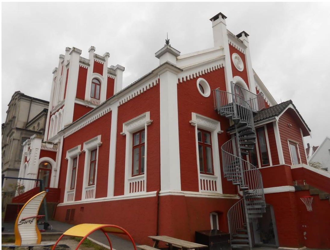
Figur 7: Den romanske gavlveggen hvor også altanen ligger, er et annet arkitektonisk hovedmotiv. Innbyggingen og rømningstrappen er lite tilpassede tiltak på en eksponert fasade (Foto: Byantikvaren 2015).
