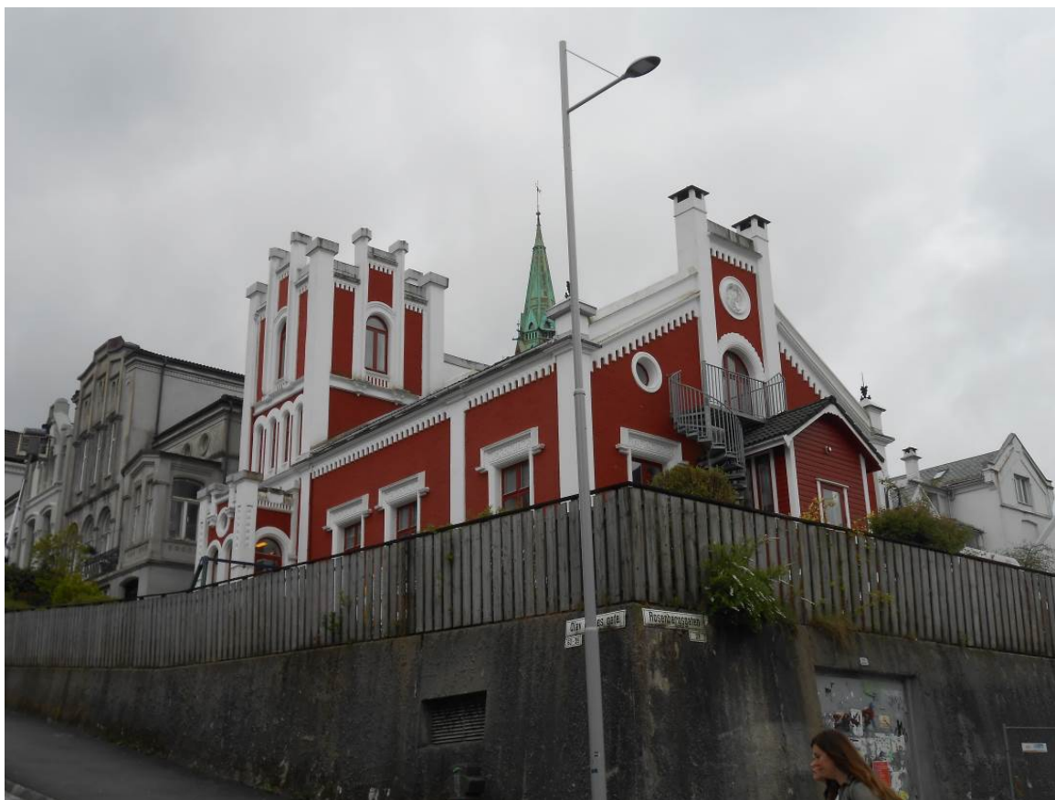
Figur 13: Plankegjerdet som rammer inn eiendommen yter ikke bygningen eller villakvartalet rettferdighet. Det bør på sikt vurderes å erstatte dette med et gjerde som er bedre tilpasset strøkskarakteren (Foto: Byantikvaren 2015).
