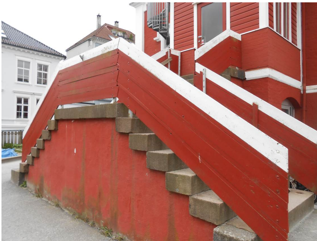
Figur 9: Den tofløyede trappen som leder fra hagen og opp til verandaen. Rekkverket her har historisk vært et transparent smi- eller støpejernsrekkverk som tillot det symmetriske trappeløpet å fremstå som en helhet (Foto: Byantikvaren 2015).
