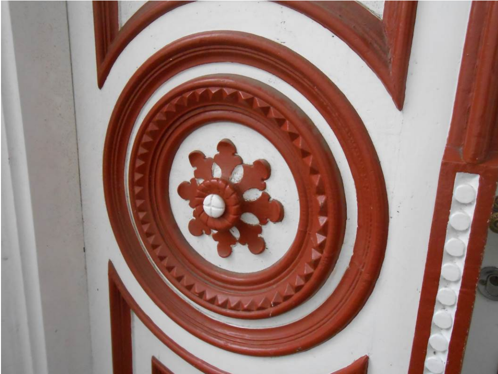
Figur 11: Inngangsdøren er opprinnelig og har rike utskjæringer og rike profiler (Foto: Byantikvaren 2015).
