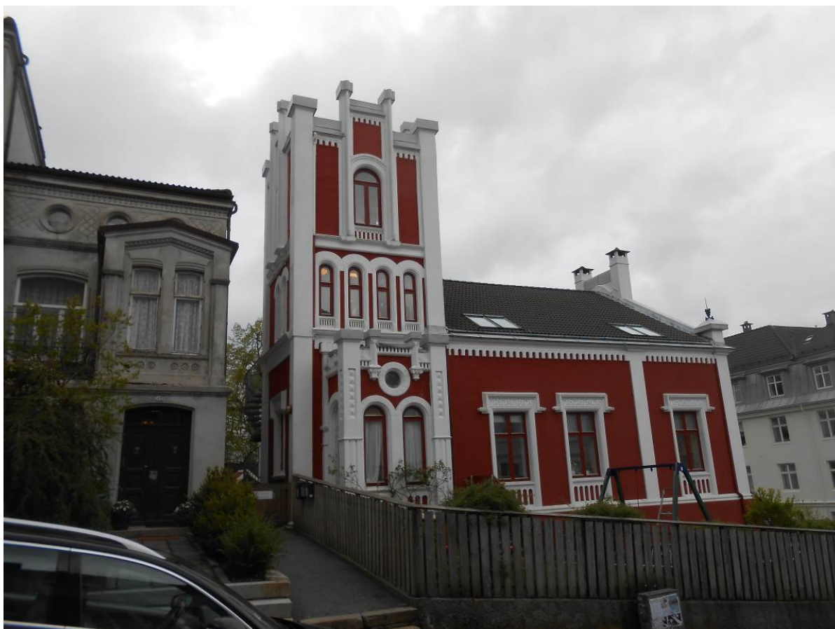
Figur 6: «Dette lille slott var det første huset som ble oppført i dette strøket, og er et bergensk Oscarshall i miniatyr» (sitat, Henrik Von Achen). Som på Oscarshall er tårnet bygningens hovedmotiv, og markeres også ved et lite karnapp og høy tetthet av buede vindu (Foto: Byantikvaren 2015).
