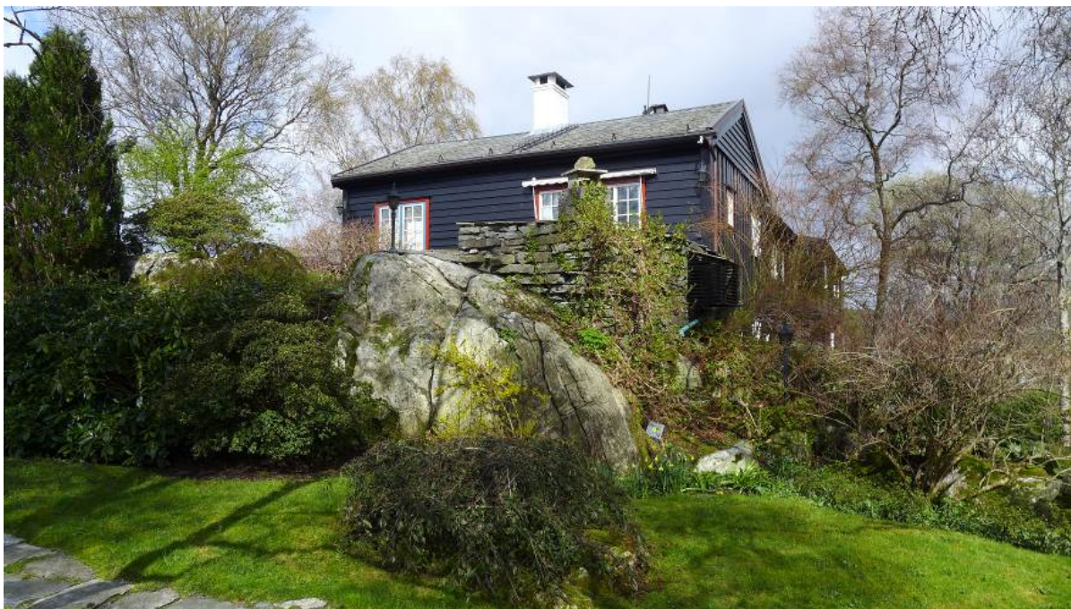
Figur 6. Hagen og de laveste delene mot sør, som har enkle veggflater bare brutt av vindus- og døråpninger med enkel belistning (Foto: Byantikvaren 2015).
