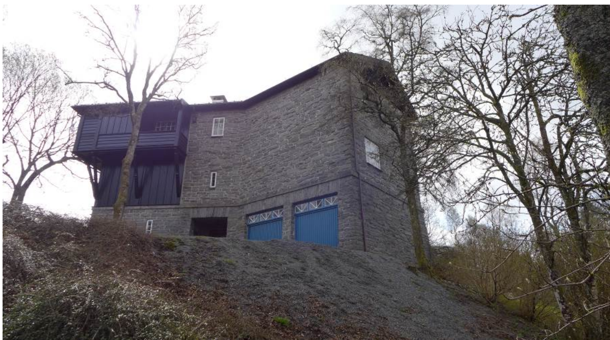
Figur 3. Nordfasaden til Siljustøl. Et viktig fellestrekk for Bergensskolen var den uttalte inspirasjonen fra tradisjonell vestlandsk byggeskikk, og til dels omfattende bruk av lokal gråstein (Foto: Byantikvaren 2015).
