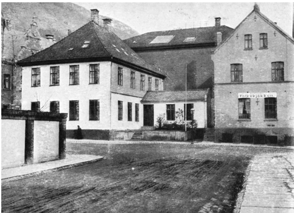
Figur 3. Magistratsbygningen til venstre fotografert rundt 1920, da dens høyre fløy ennå var en selvstendig bygning og huset Bergens Folkekjøkken, oppført i 1870. Vi ser at andre etasje er i tre med murforblending mot gaten. Bygningen i bakgrunnen er den gamle politistasjonen, nå revet (Kilde: http://fotomuseum.bergen360.no ).
