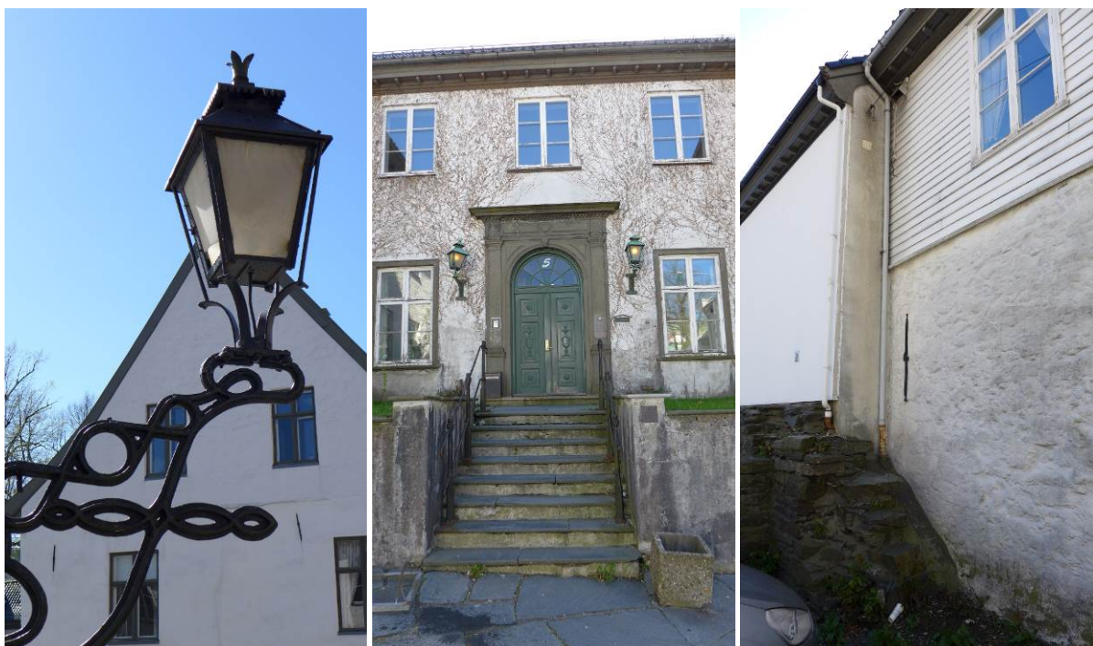
Figur 15. Smijernslykt på NØ-hjørnet mot Allehelgens gate og hovedinngangen til bygningen. Til høyre ses baksiden av den fredete fløyen og den utskutte bakveggen i mellombygningen (Foto: Byantikvaren 2015).
