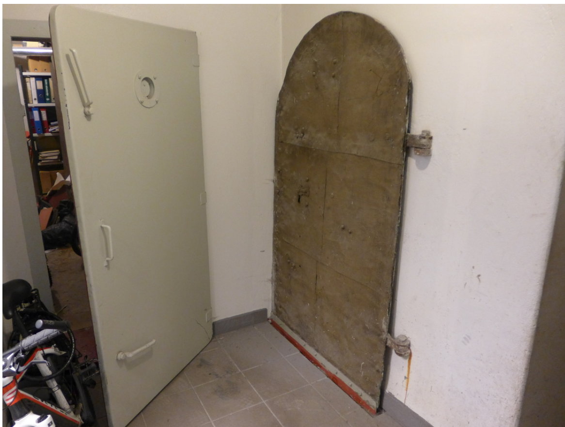
Figur 29. I kjelleren under den ombygde folkekjøkkenbygningen i sørfløyen, er det bevart en gammel jerndør, fremdeles hengslet til veggen, i et sterkt ombygget rom. Døren, som har stor kulturminneverdi, vitner om at her har det antagelig vært en brannsikker kjeller (Foto: Byantikvaren 2015).
