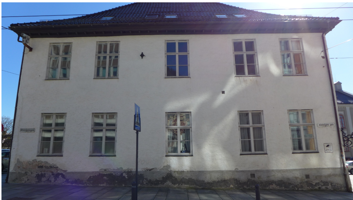
Figur 13. I østfasaden til den gamle fløyen er vindusåpningene symmetrisk plassert i rytme 2-1-2. Frem til ombyggingen på 1920-tallet var hovedinngangen der hvor det midterste vinduet er i 1. etasje (Foto: Byantikvaren 2015).
