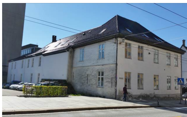
Figur 10. Bakplassen til Magistratbygningen i dag (Foto: Byantikvaren 2015).
