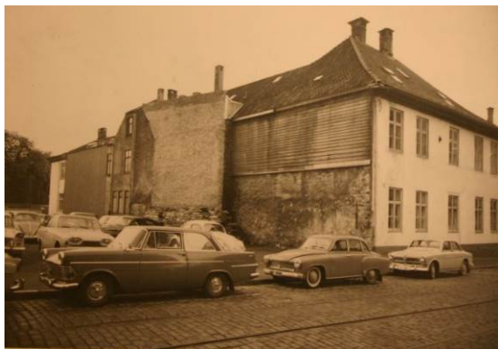
Figur 9. Situasjonen på bakplassen like etter at politihusene ble revet på 1960-tallet. Vinduene i den fredete bygningsdelen er på dette tidspunktet ikke brutt ut (Kilde: Riksantikvarens arkiv).
