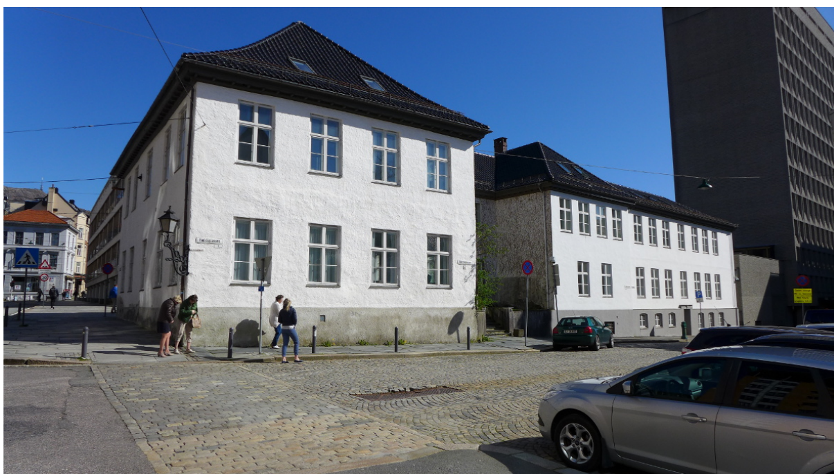
Figur 11. Magistratbygningen med den eldste delen til venstre og det nyere tilbygget til høyre for portrommet (Foto: Byantikvaren 2015).
