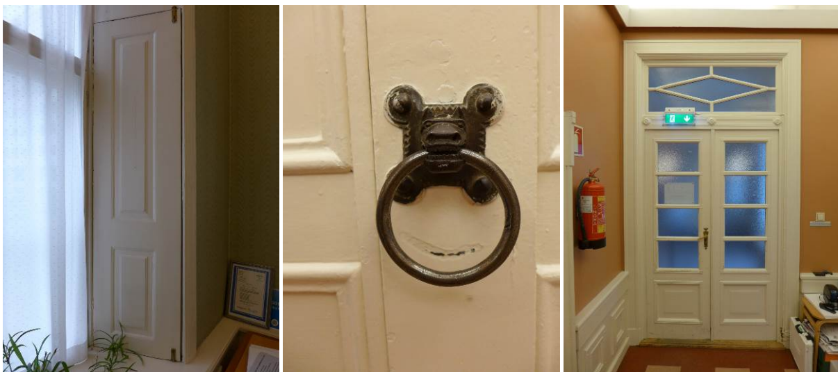
Figur 18. Detaljbilder fra interiøret i nordfløyen: Integreerte vinduslemmer, beslag i hvelvdøren og dør til vestibylen i mellombygningen (Foto: Byantikvaren 2015).
