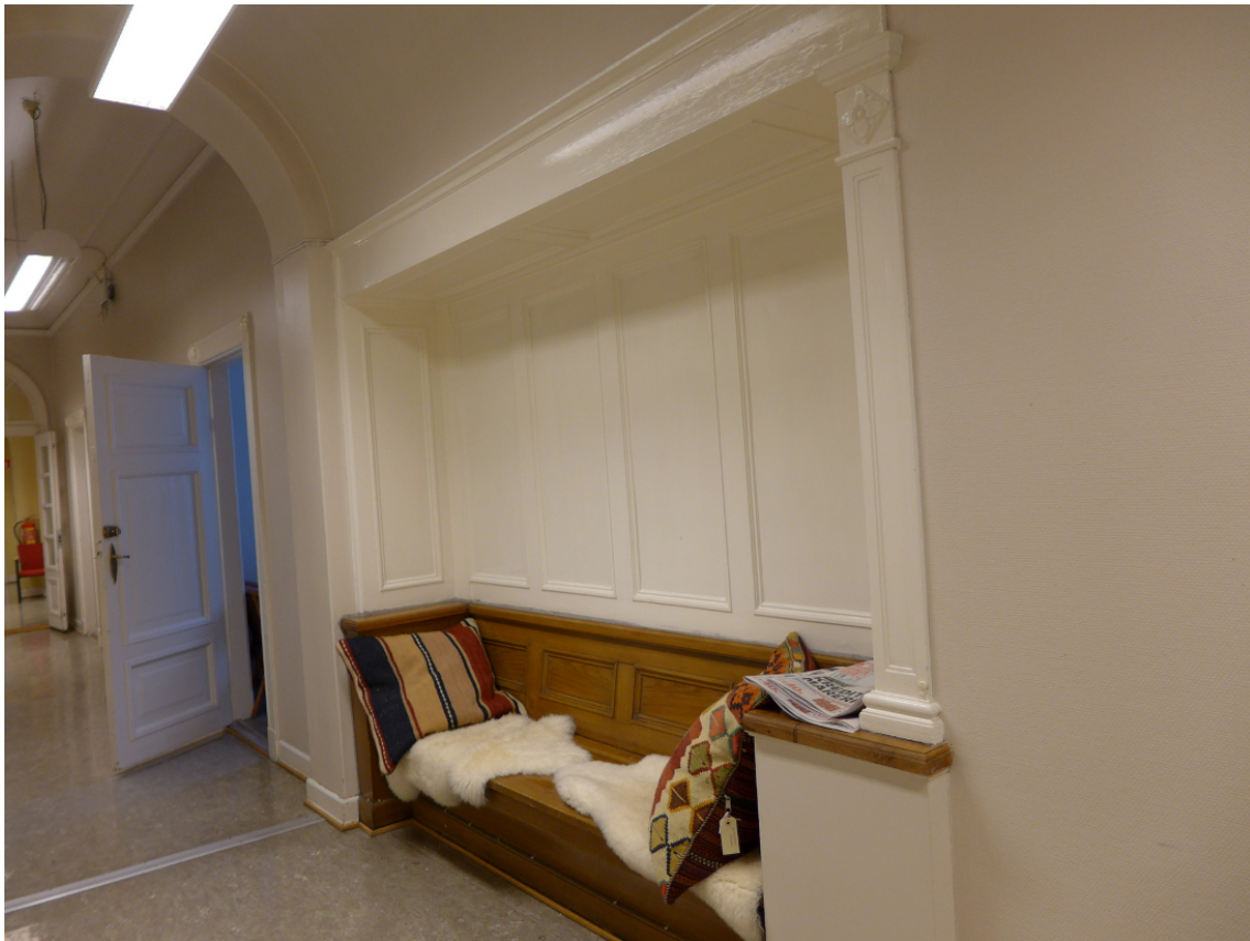
Figur 25. Veggnisje med fast trebenk i korridor i 1. etasje i sørfløyen (Foto: Byantikvaren 2015).
