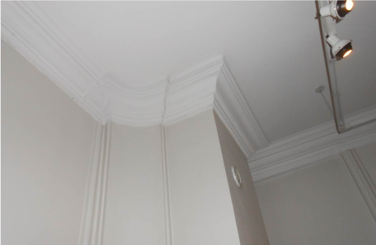
Figur 19: Profilert listverk i tak (Foto: Byantikvaren, Bergen kommune 2015).
