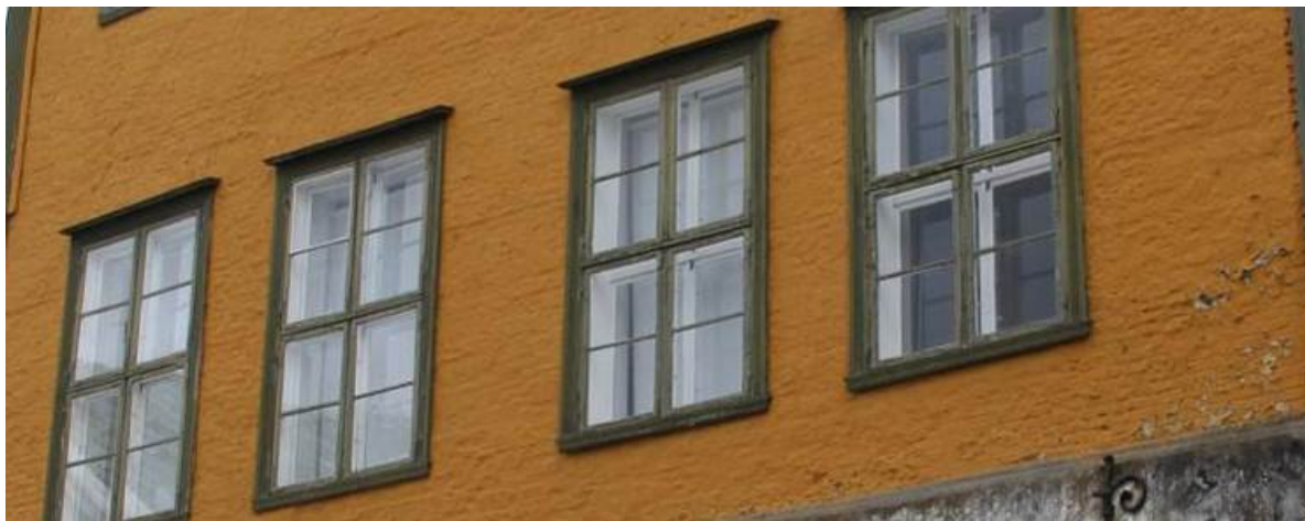
Figur 9: Vinduer på Latinskolens vestfasade (Foto: Byantikvaren, Bergen kommune 2015).
