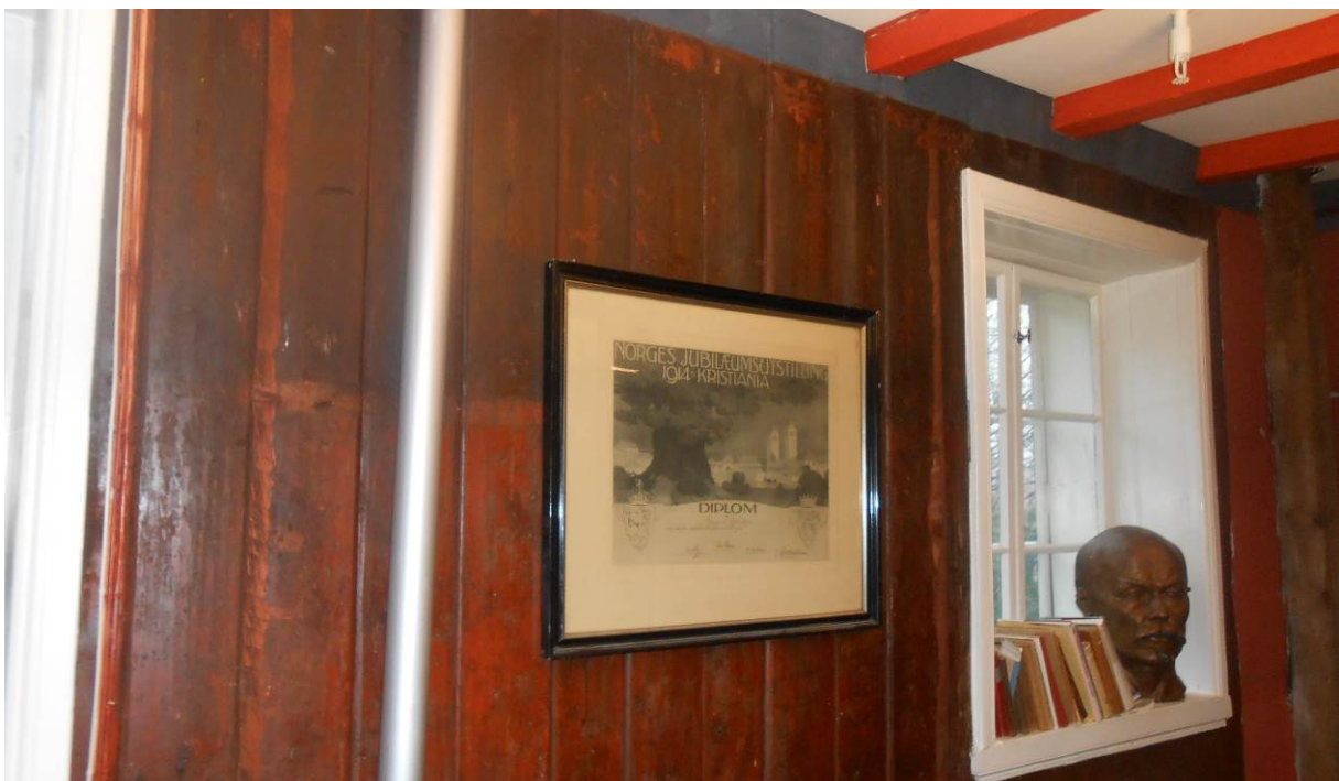
Figur 18 (under): Vegg med eldre, stående innerpanel (Foto: Byantikvaren, Bergen kommune 2015).
