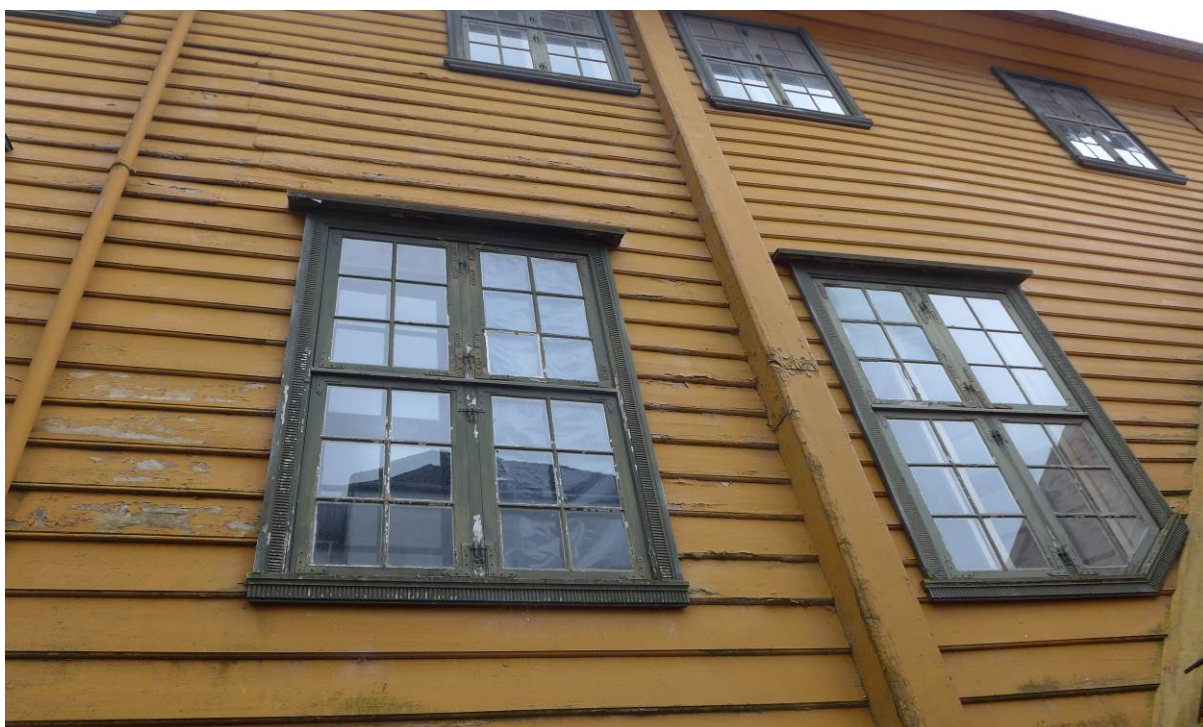
Figur 8: På Latinskolens nordfasade er det stort sett smårutete 1700-talls vindu, med tverriflede gerikter (Foto: Bergen kommune, Byantikvaren 2015).
