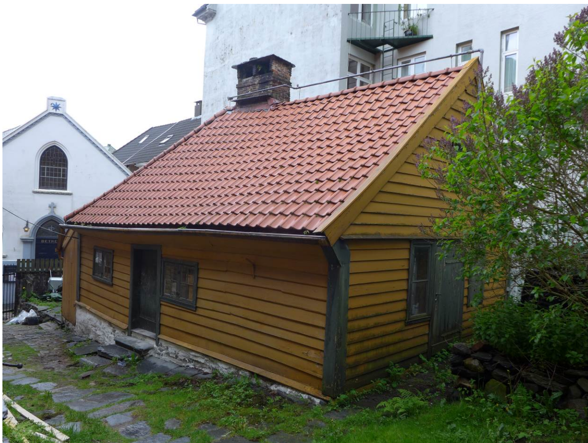
Figur 11: Foto av Bryggerhuset med liggende kledning, rød enkeltkrum teglstein på taket og stor pipe av tegl (Foto: Byantikvaren, Bergen kommune 2015).
