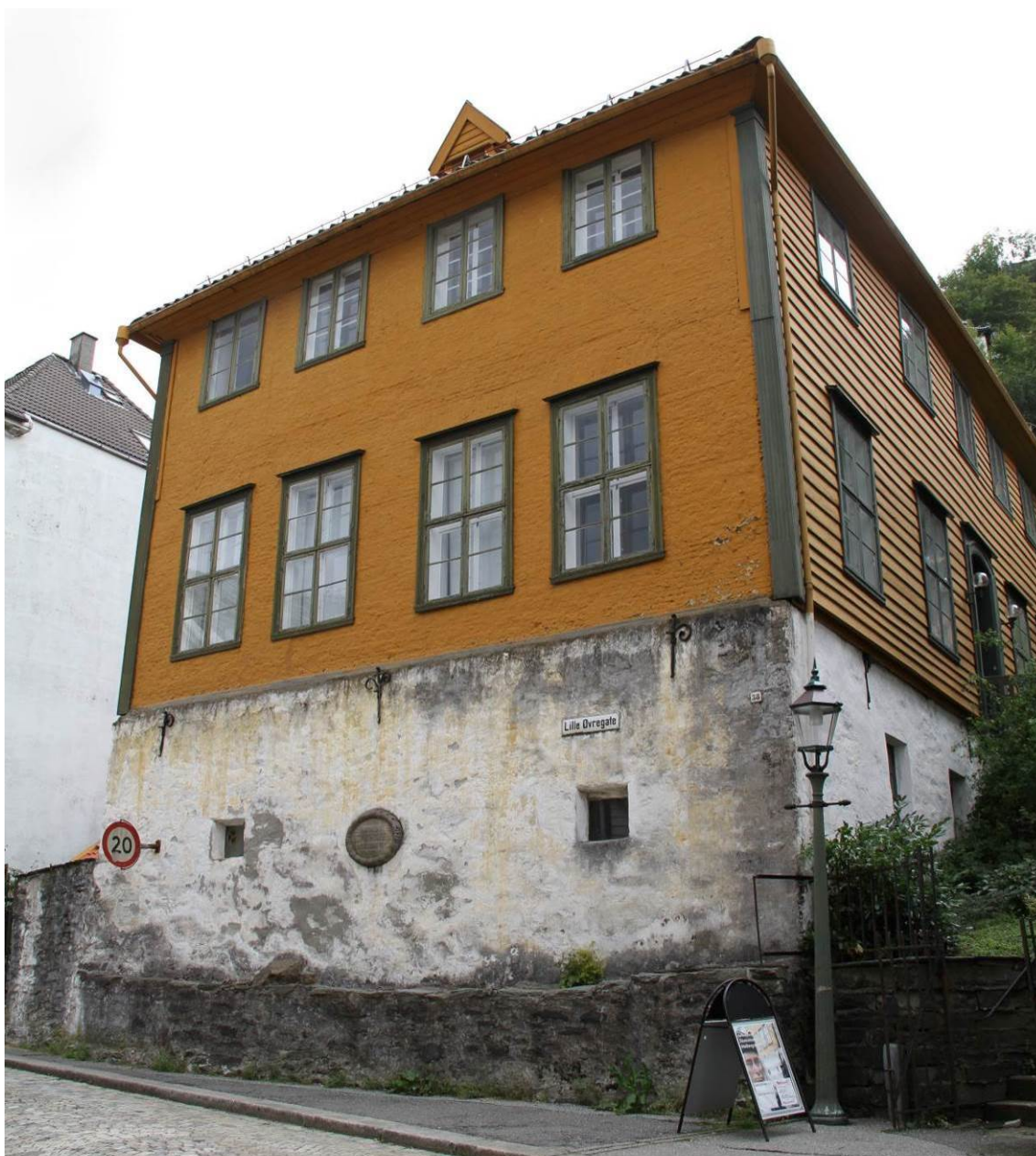
Figur 10: Foto av vestgavlen ut mot Lille Øvregate (Foto: Byantikvaren, Bergen kommune 2015).
