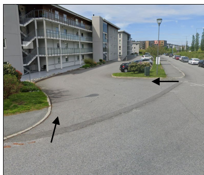
Fig. 7. Innkøyrsele til Kvernslåttvegen 11 og 13
