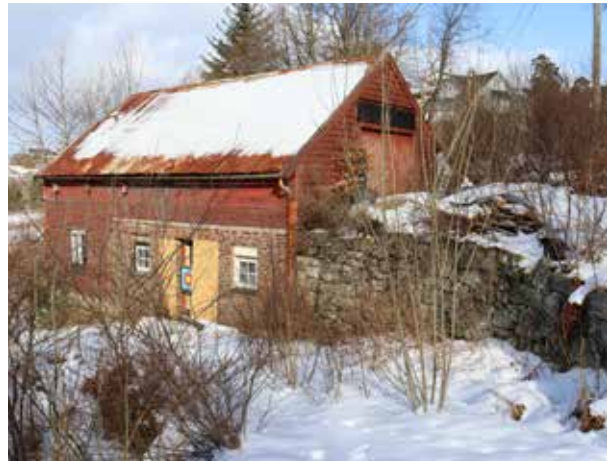
Fasadar mot sør og aust med låvebru.
