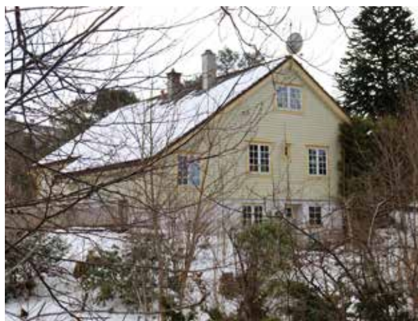
Dagens situasjon – fasadar mot nord og vest.
