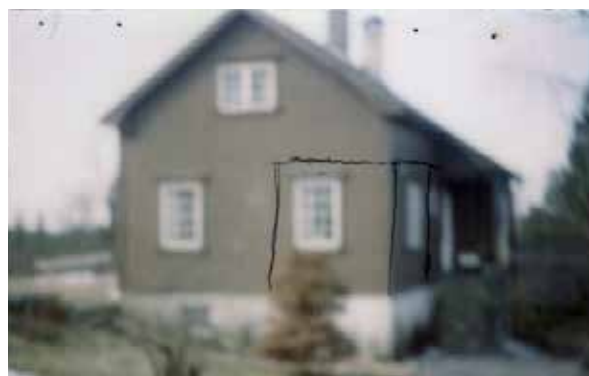
Eit noko uklart bilde frå Byggesaksarkivet viser korleis bustaden opphavleg så ut.
