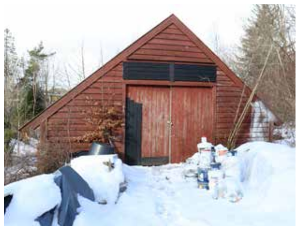
Fasade mot aust.
