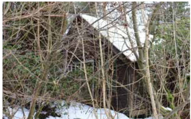
Kvernslåttvegen 24, fasade mot nord.
