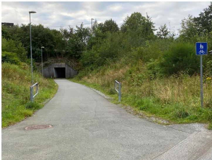
Figur 4. Undergang ved Folldalsheia.
