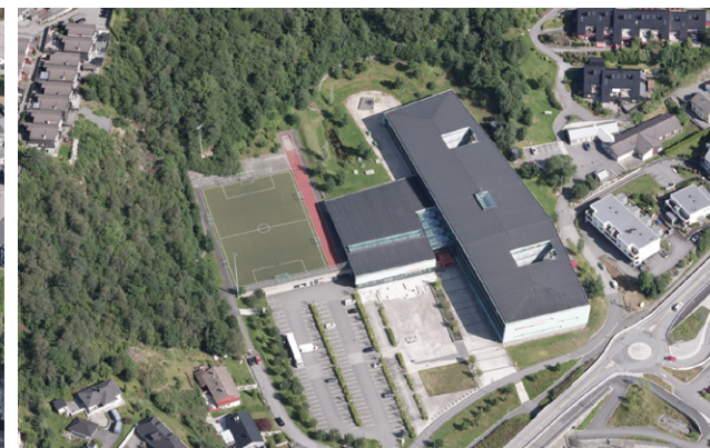
Nordahl Grieg VGS. Foto: 1881.no
