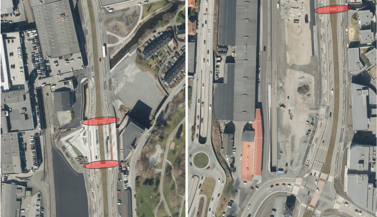
Figur 2-2 Plassering av gangfelt uten signalregulering ved Mindemyren bybanestopp t.v. og lengre sør i Kanalveien t.h. Flyfoto hentet fra kommune kart.com.
