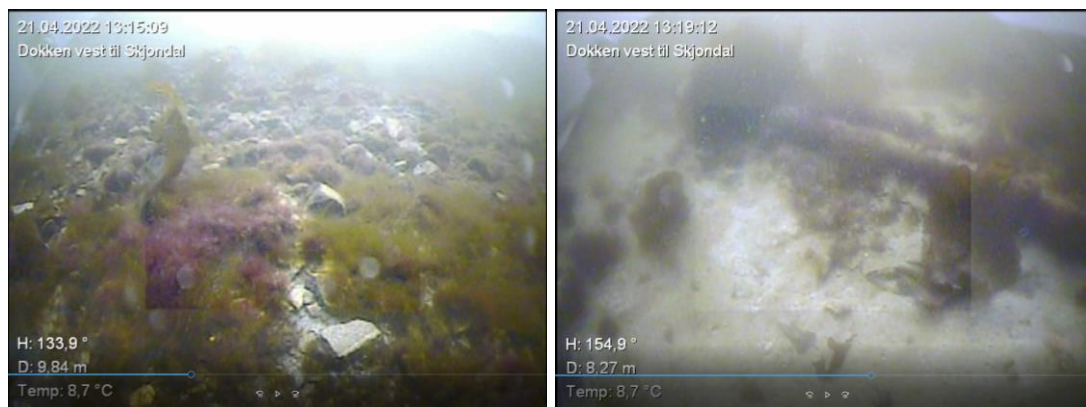
Figur 14 Bilder fra filming sørøst og nord for Skjøndal slipp. Bildet til venstre viser et heldekkende erosjonssikringslag, men bildet til høyre viser området nær en ledning som ikke ble tildekket som del av tiltaket.
