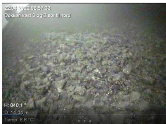
Figur 16 Heldekkende erosjonssikringslag utenfor Dokken Vest kai 3 og 2
