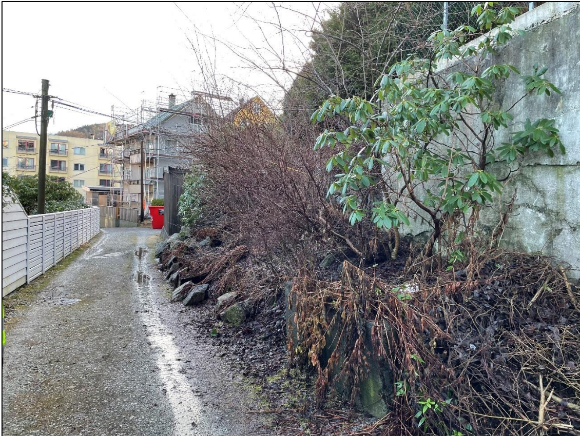
Figur 4. Trase 2 (bildet tatt mot sør). Berg er ikke blottet og eksisterende trase er avgrenset av etablerte murer.
