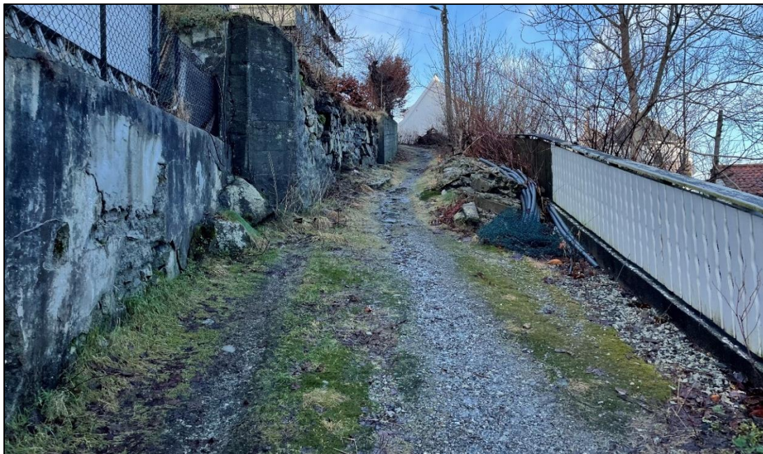
Figur 5. Trase 2 (bildet tatt mot nord) er med etablerte murer på hver side. Til venstre i bildet er større antatte større blokker av berg eksponert.
