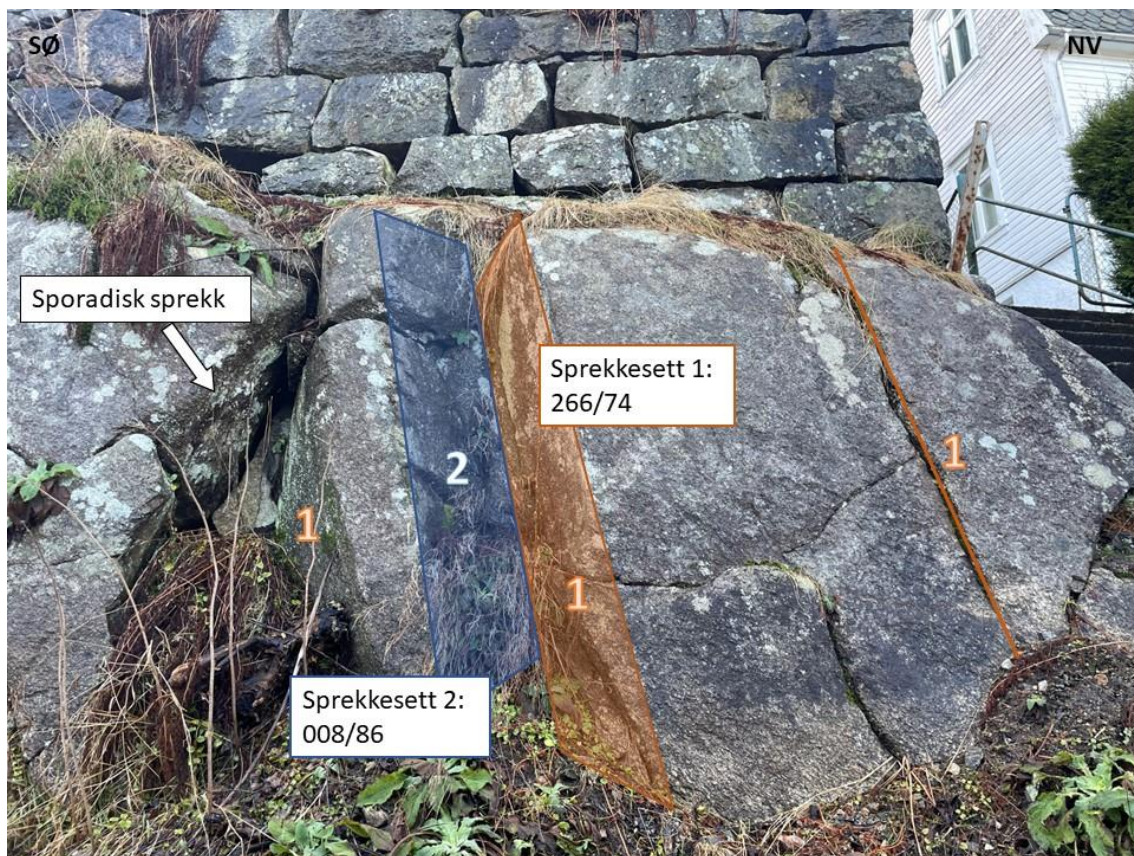
Figur 12. Sprekkesett i skjæring. Sprekkesett 1 i oransje, sprekkesett 2 i blå og en sporadisk sprekk markert med hvit pil. Bergflaten viser ingen tydelig foliasjon. Sprekkeorientering oppgitt som strøk/fall.
