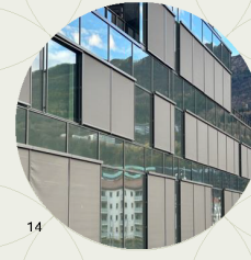
14 Solavskjerming som gir et tett og lukket uttrykk.
