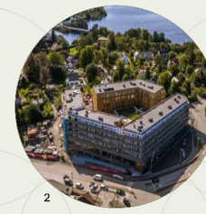
2 Sanering av kulturmiljø
