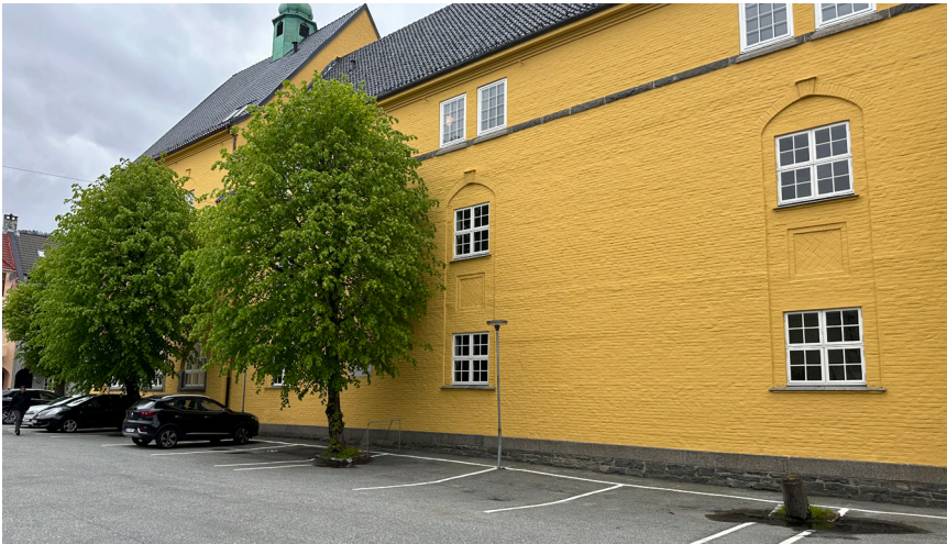
Bildet fra dagens situasjon. Harde flater og biler preger dagens rom, men med innslag at materialer og elementer som skal videreføres. Bla. flotte bytrær, robust vegetasjon, natursteinskanter og vinkeljærnsrekkverk.
