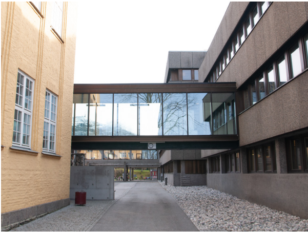
Eksistende gangbro mellom Sydneshaugen skole og HF-bygget.
