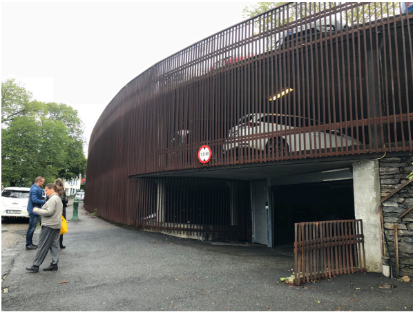
Eksisterende parkeringsgarasje mot Dokkeveien, buet form.
