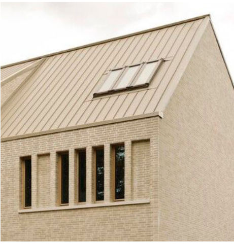
Gesims detalje med likhet mellom tak og fasade.
