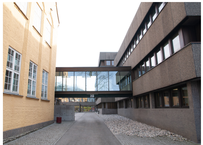
Passasje fra Vinjes gate
