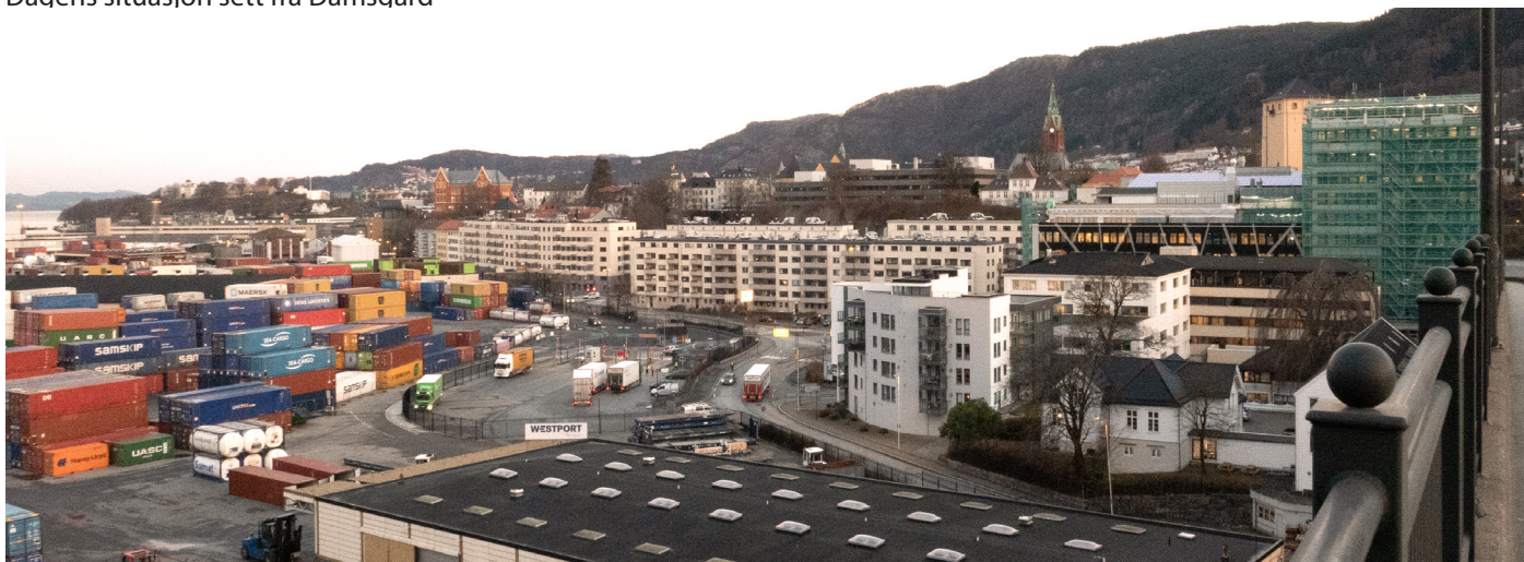
Dagens situasjon sett fra Puddefjordsbroen
