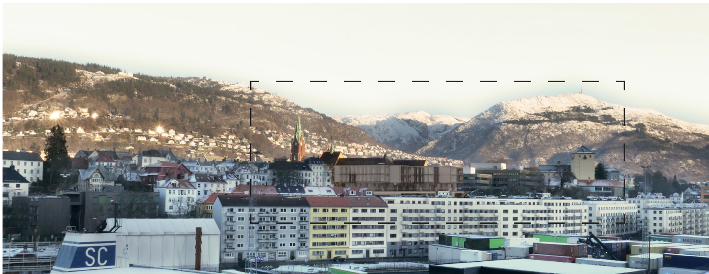
Fjernvirkning av alternativ A sett fra Dokken
