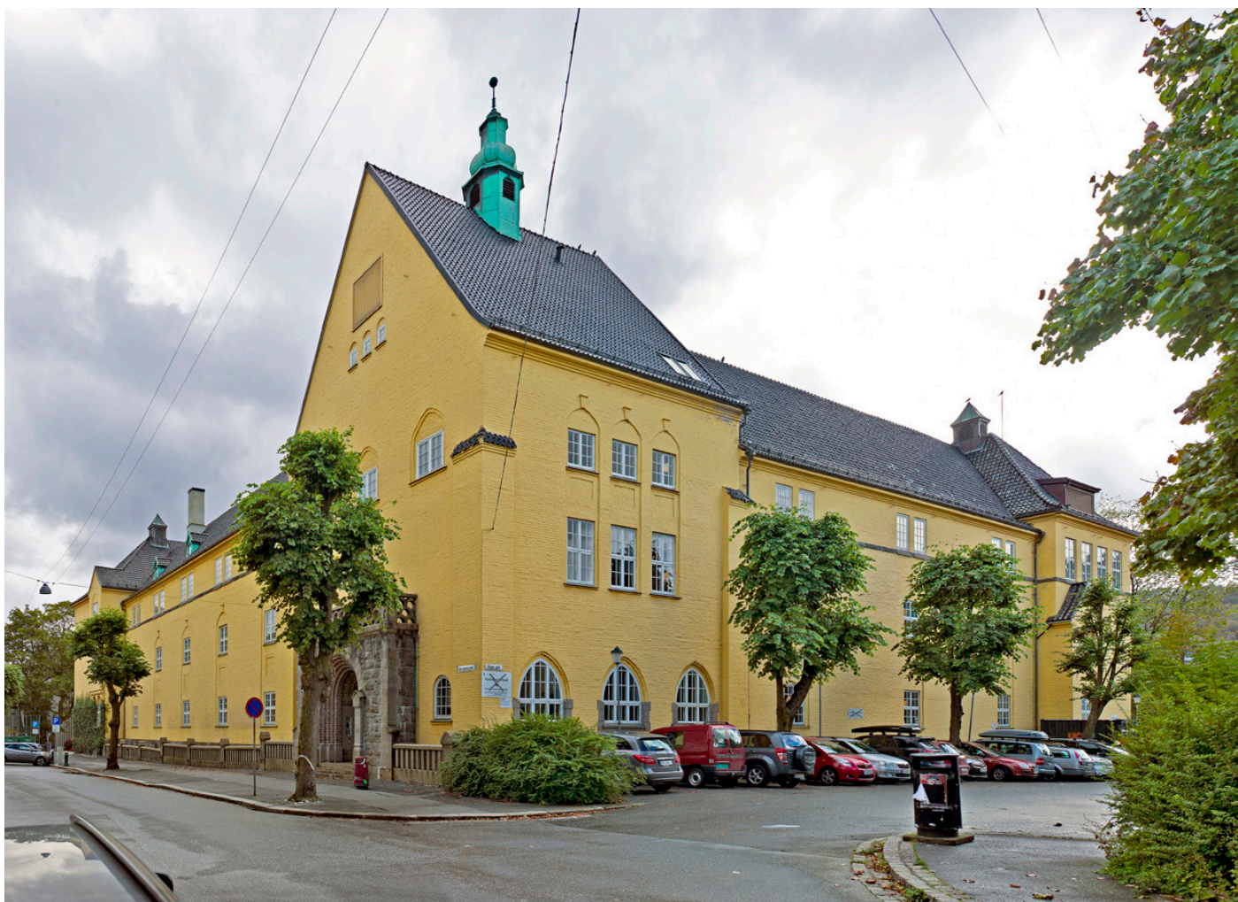
Sydneshaugen skole (KM1) - Fra Ivar Aasens gate
