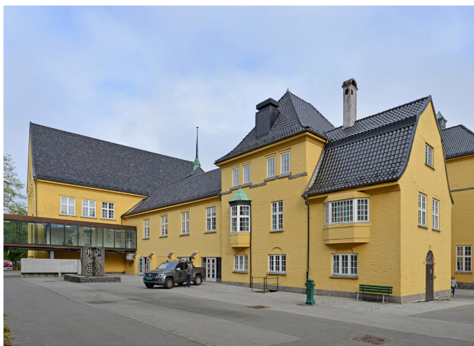
Sydneshaugen skole (KM1) - Fra Sydneplassen
