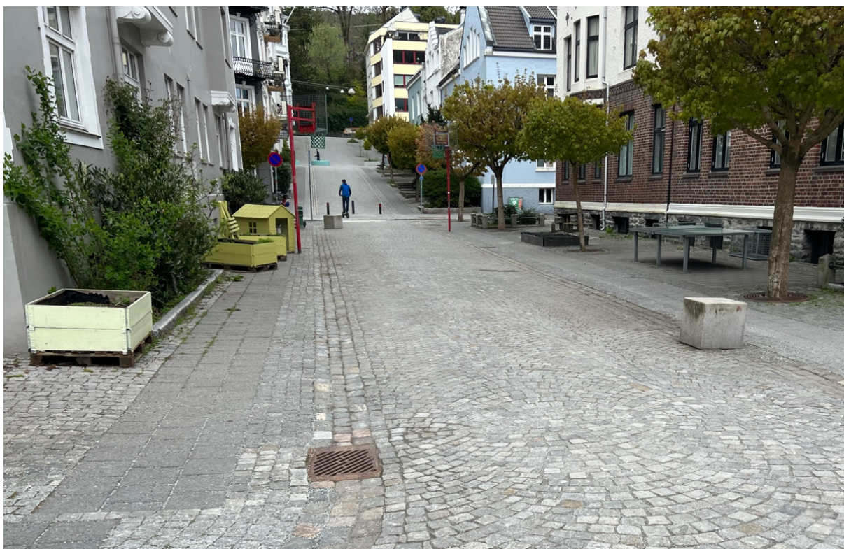
Figur 2-2: Eksempel på gate som allerede er sanert (Zetlits gate).
