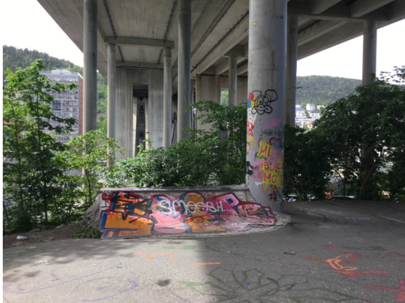
Figur 3-70 Bilde fra under Puddefjordsbroen, et landskapsrom med helt særegne kvaliteter
