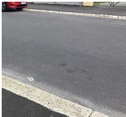
Figur 3-61 Hel og fin asfalt med kvalitetskanter, gir et godt inntrykk, men har lavere standard enn for eksempel materialbruken i Welhavens gate.
