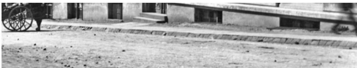
Figur 2-35. Bildet fra Wollfs gate viser hardpakket grus og kantstein opp til et hellebelagt fortau.
