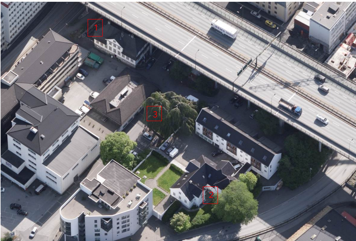
Figur 2-16 Flyfoto som viser de tre bygningene som omfattes av vern, nummerert i teksten som i bildet.
