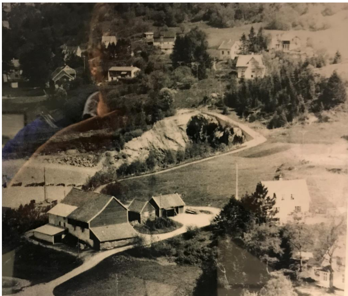
Figur 4-60 Gården til Lars Rå, våningshus ferdig oppført 1948 på dagens lokalisering. Kilde: Privat
