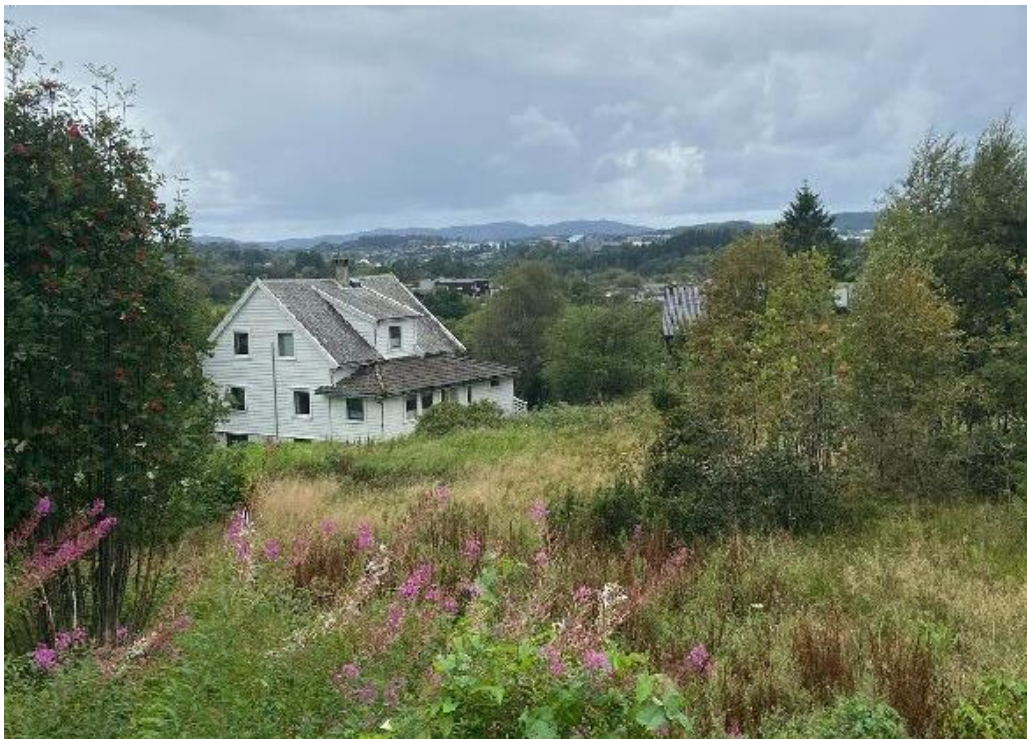
Figur 19 - Dagens Våningshus sett fra øst mot vest
