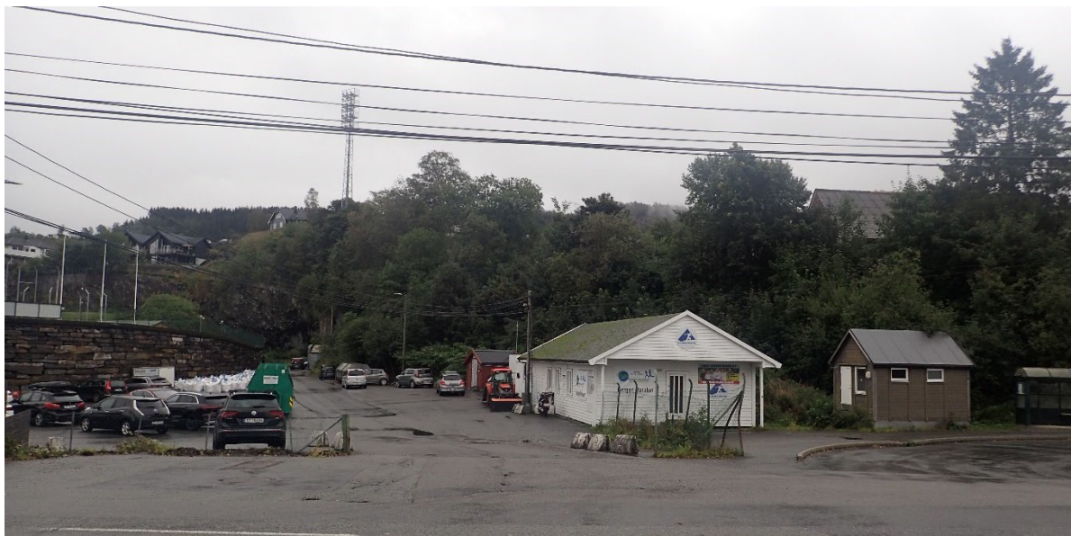
Figur 19. Oversiktsbilde av skråningen ned mot Fana stadion i nordre del av planområdet. Bildet er tatt mot sørøst. Foto: Multiconsult september 2020.
