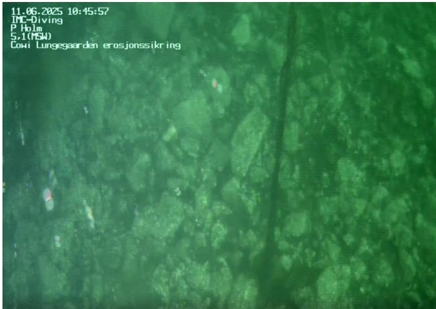
Figur 19 Heldekkende erosjonssikringslag bestående av 20/120 mm masse i delfelt 2B ved utløpet av Store Lungegårdsvannet
