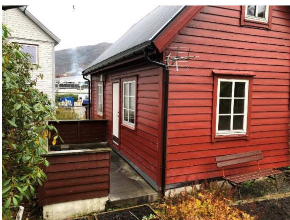
Figur 5-11 Kanalveien 92 sett mot nordøst.
