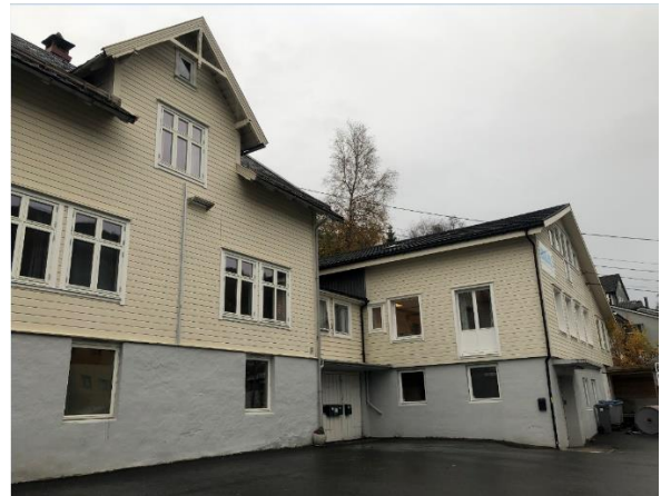
Figur 5-25 Det eldste bygget til venstre og det nyere bygget til høyre i bildet. Sett mot sør.
