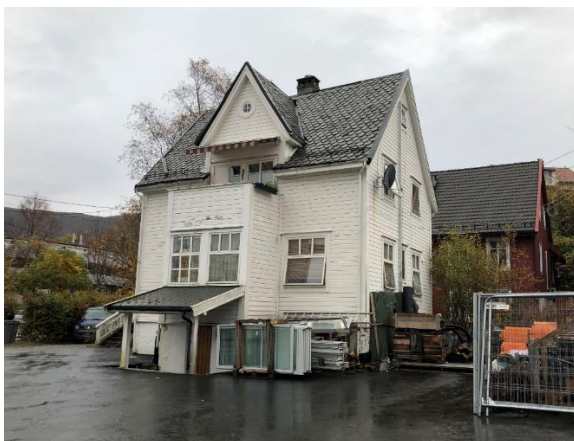
Figur 5-7 Elvebakken 3 sett mot øst.
