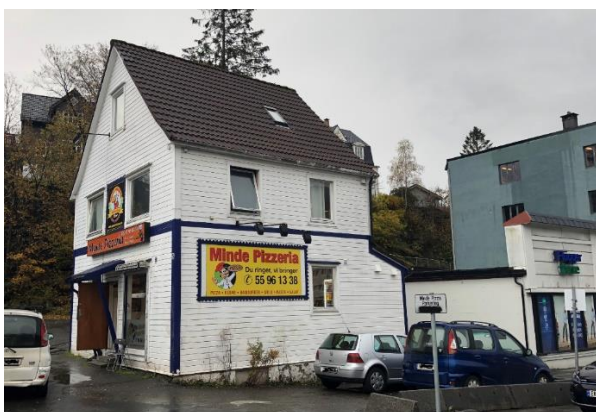
Figur 4-7 Conrad Mohrs veg 5 sett mot sørøst. Næringsbygg i Conrad Mohrs veg 7 og 9 til høyre.
