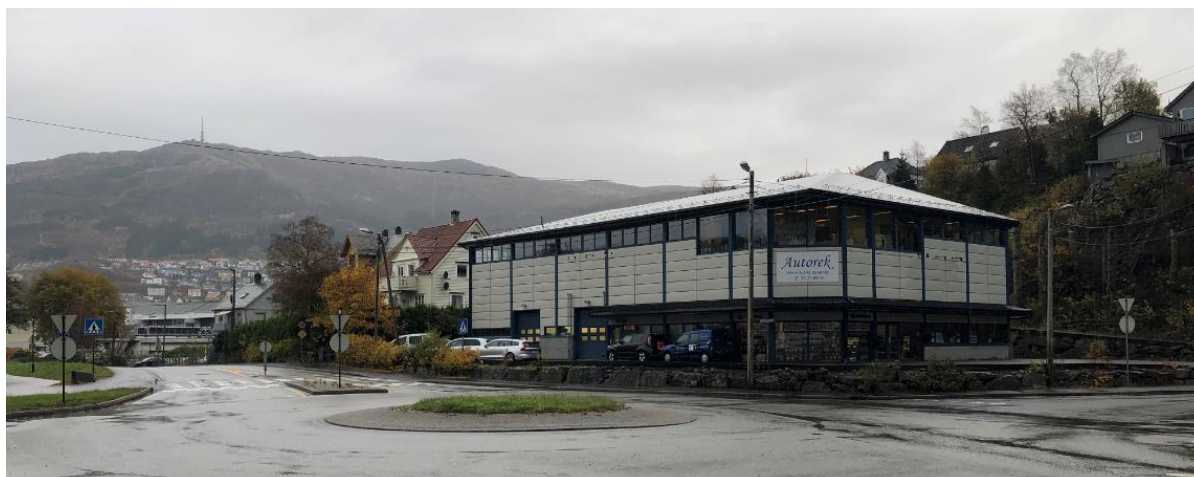
Figur 5-21 Kanalveien 98 sett mot nordøst.
