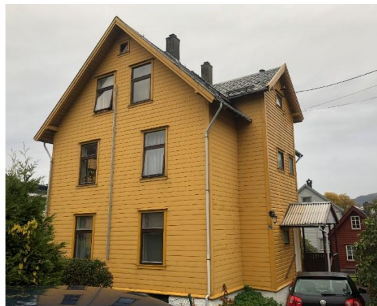
Figur 5-14 Kanalveien 94 sett mot nord.
