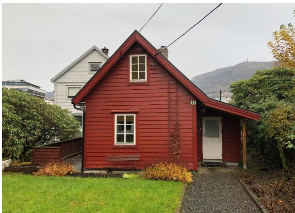
Figur 5-9 Kanalveien 92 sett mot nord.
