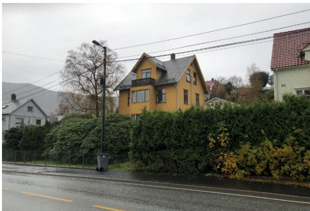
Figur 5-13 Kanalveien 94 sett mot nordøst.
