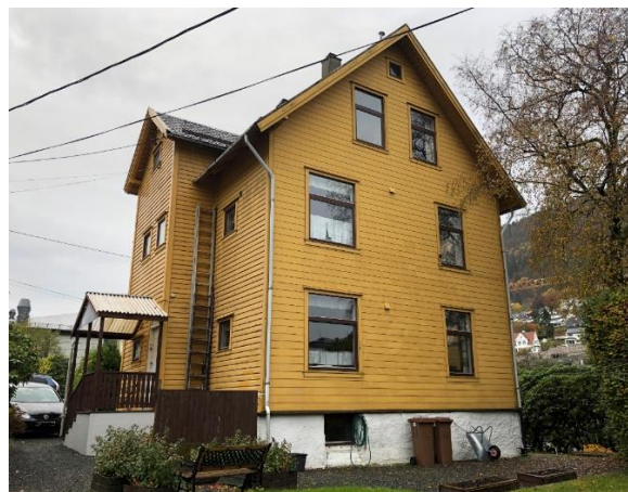
Figur 5-16 Kanalveien 94 sett mot sørvest.
