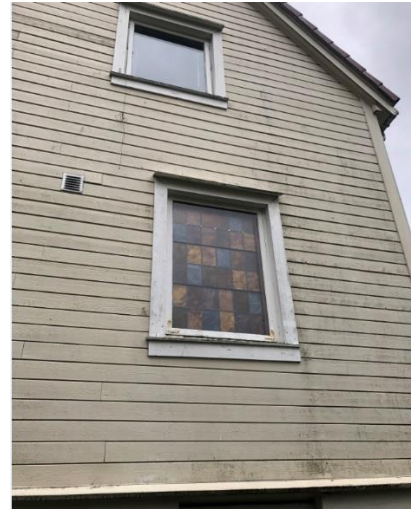
Figur 5-18 Glassvindu på nordveggen.
