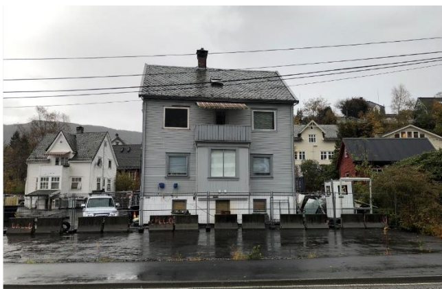
Figur 5-1 Elvebakken 1 sett mot øst.
