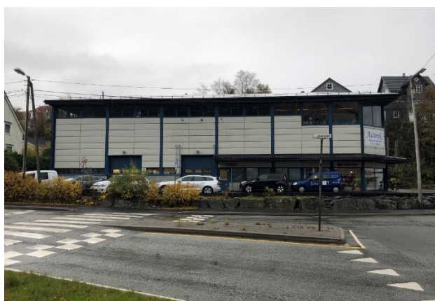
Figur 5-22 Kanalveien 98 sett mot øst.
