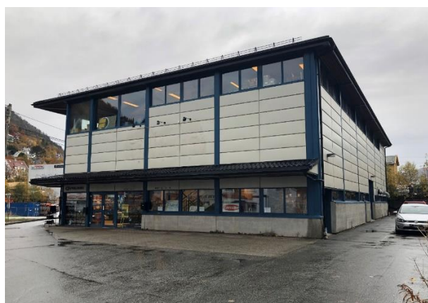
Figur 5-23 Kanalveien 98 sett mot nord.
