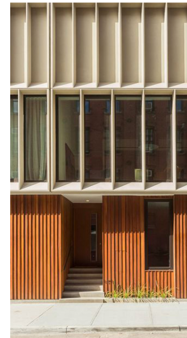
Inngangsparti bør være overbygget eller trukket inn i fasaden for å beskytte mot regn.
