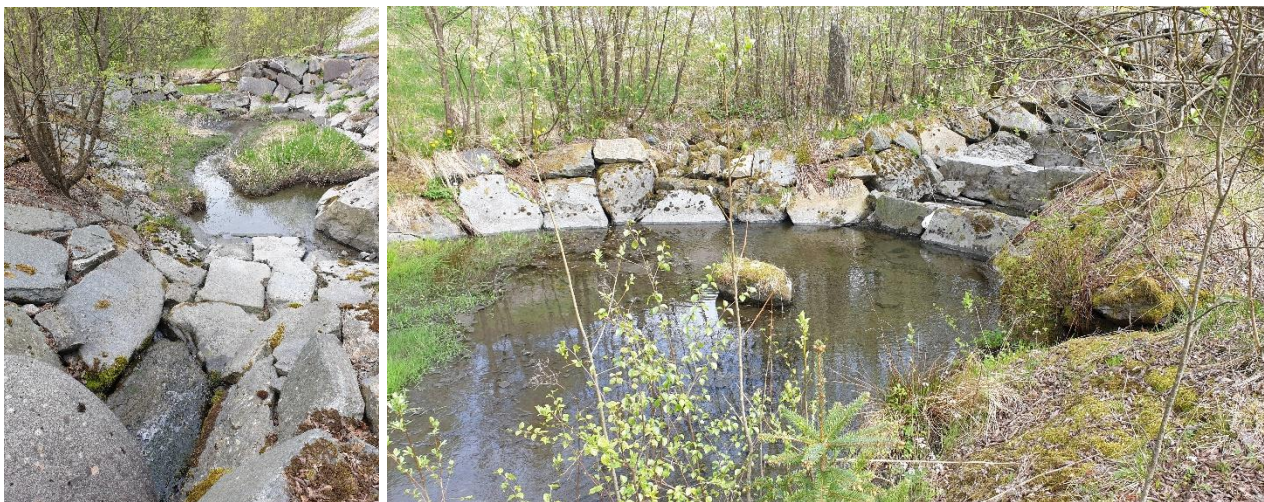
Figur 3-18: Flomsikring i øvre deler av bekken. Foto: Magnar Bjerga, Multiconsult.
