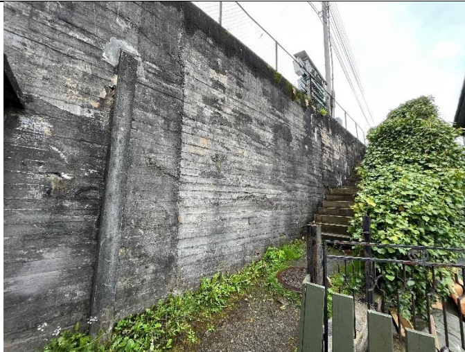
Bilde 2: Støttemur Lille Damsgårdsveien 17.
