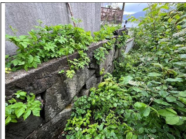
Bilde 19: Støttemur langs eiendom 153/236.
