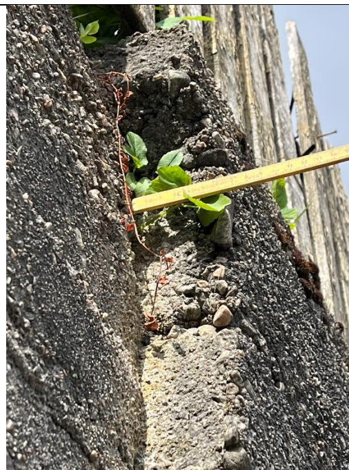
Bilde 16: Helning utøver på toppen av midtre mur.
