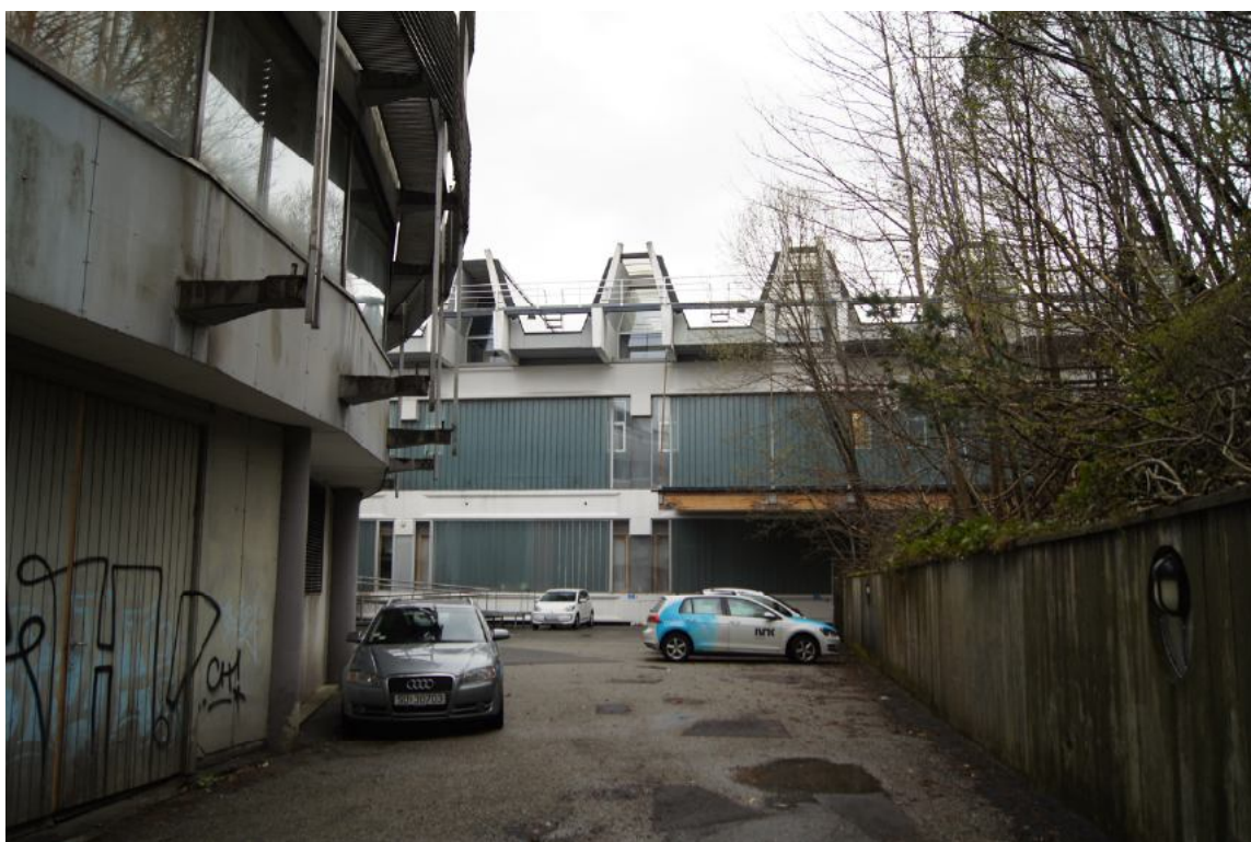
DETALJ AV ADMINISTRASJONSBYGGETS FASADE MOT AUST OG PRODUKSJONSHALLENS FASADE MOT SØR OG MUR.
