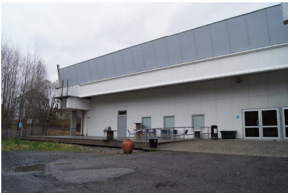
AUSTSIDA AV BYGGET, SETT MOT SØR.
