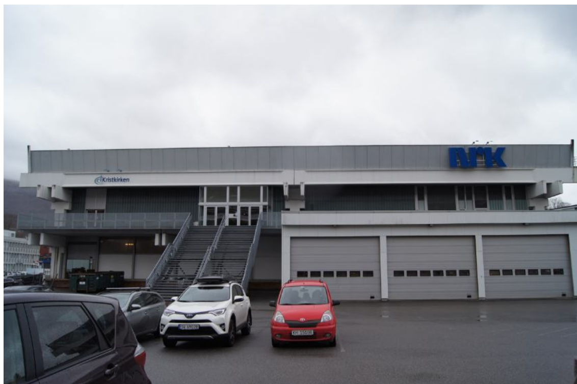
FASADE MOT VEST MED GARASJE FRÅ 1995 OG TRAPP OG NYTT INNGANGSPARTI FRÅ 2001.
