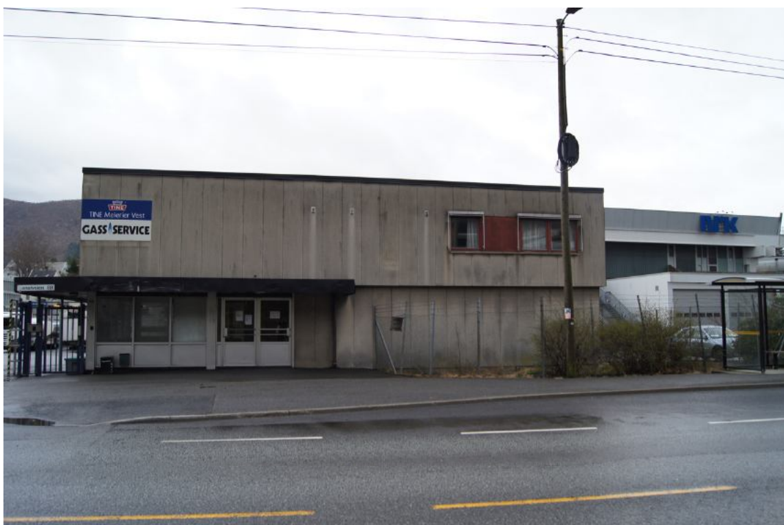
FASADE OG INNGANG MOT VEST.
