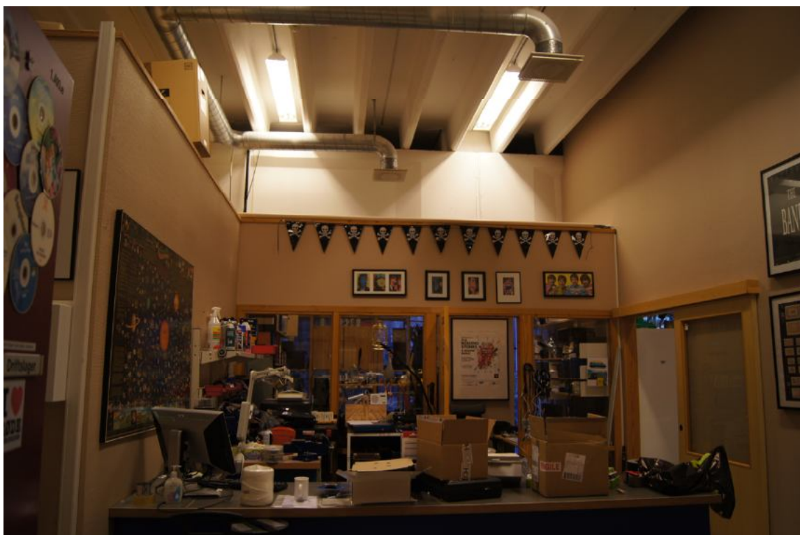
DETALJ INTERIØR I KONTROLLROM FRÅ FØRSTE ETASJE, DER DEI KONSTRUKTIVE TAKELEMENTA I BETONG KJEM TIL SYNE.
