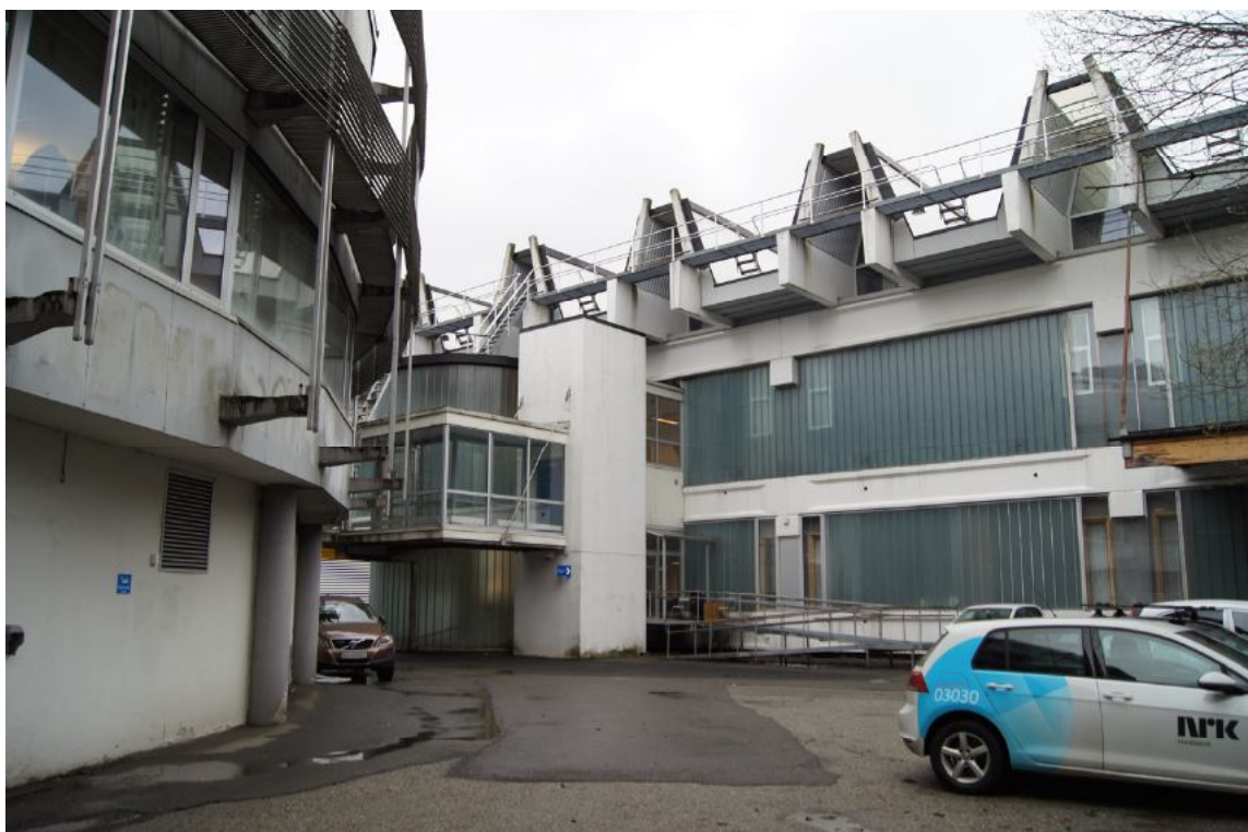
SØRSIDA AV BYGGET SETT MOT VEST, MED HEISSJAKT, RAMPE OG INNGANG AV NYARE DATO. I SEINARE TID ER DET LAGT EI GANGBRU PÅ TAKELEMENTA FOR Å LETTE OG TRYGGJE TILKOMSTEN TIL TAKET.
