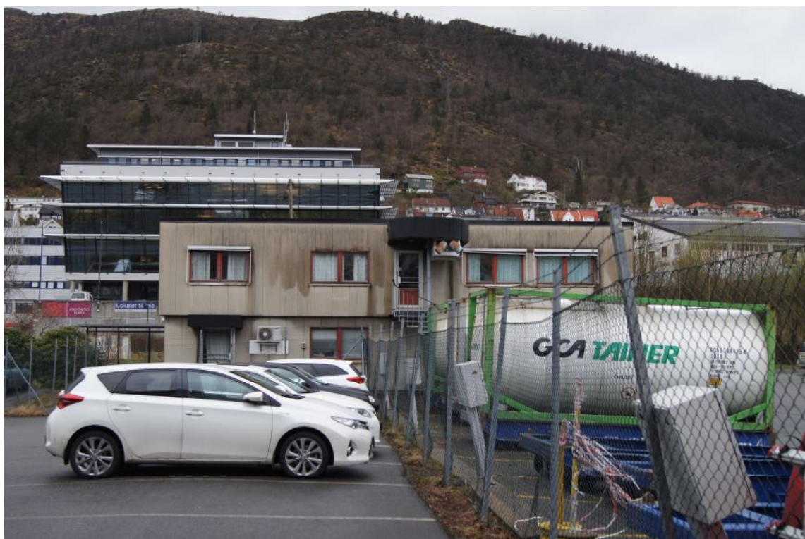
FASADE MOT AUST.
