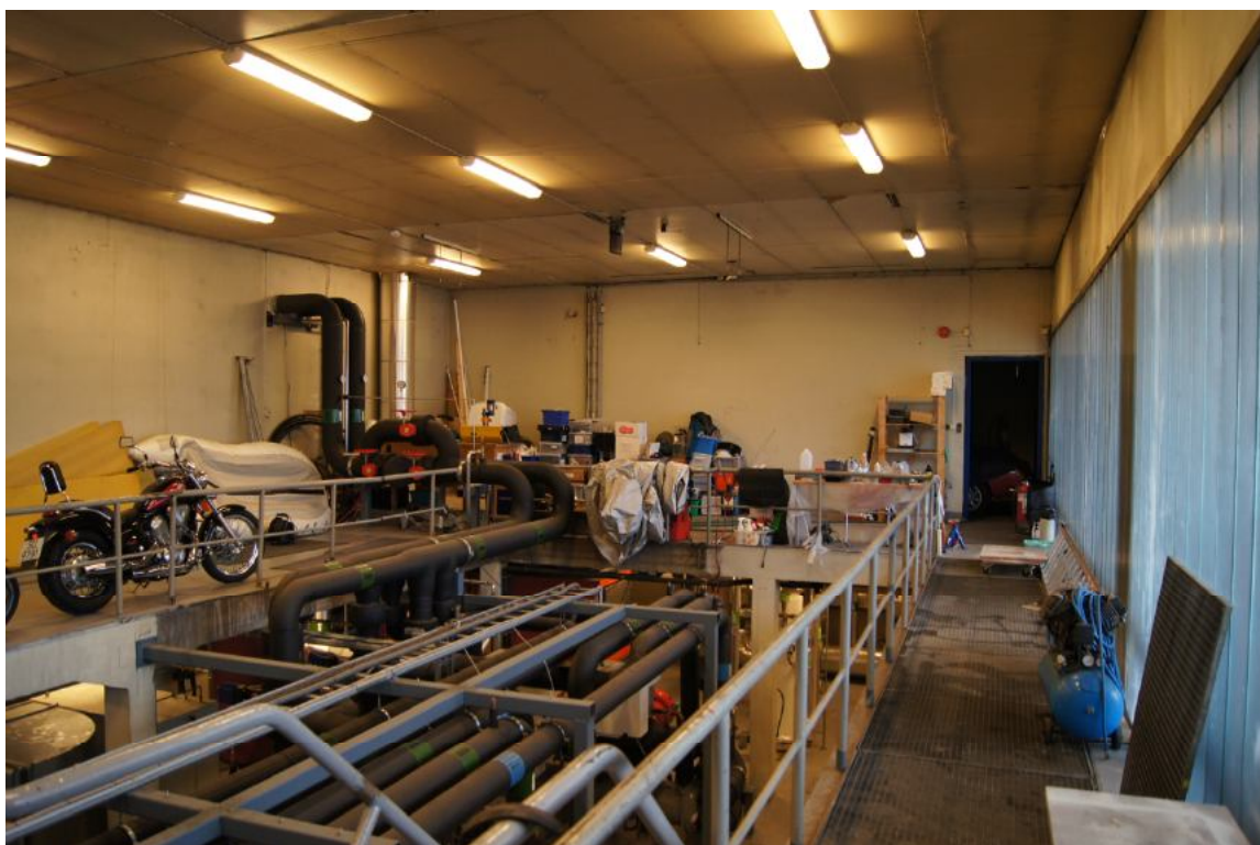
FØRSTE ETASJE (BAKKENIVÅ). I MOTSETT ENDE: GANG, FORROM, TRAFOROM OG ROM MED HOVUDTAVLE. DELER AV VEGGEN MOT NORD BESTÅR AV SAME PROFILIT SOM PRODUKSJONSHALLEN.
