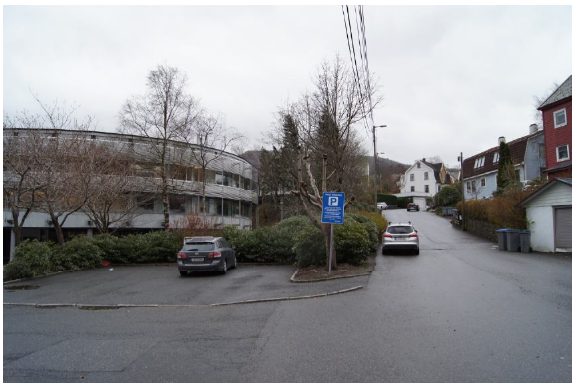
PLANOMRÅDET SETT FRÅ SØRVEST MOT AUST MED ADMINISTRASJONSBYGGET (KANALVEIEN 90) TIL VENSTRE I BILDET OG BUSTADHUS I ELVEBAKKEN TIL HØGRE (NR 5, 7 OG 12).
