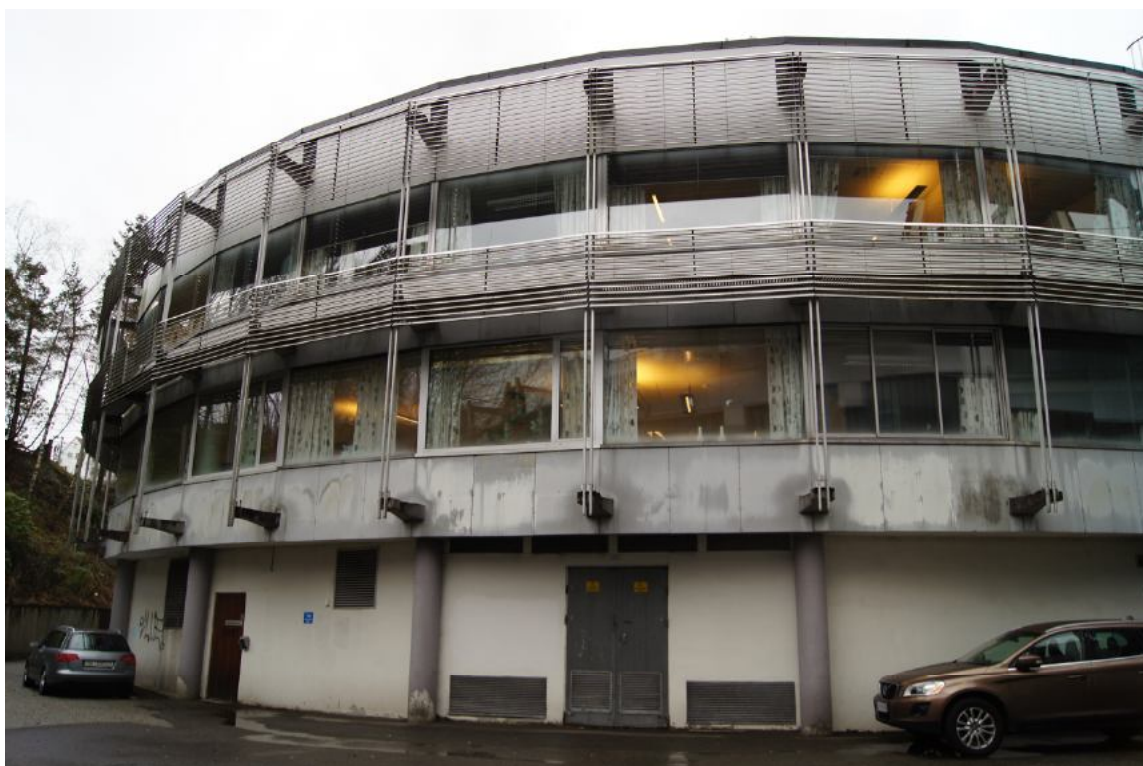
FASADE MOT AUST.
