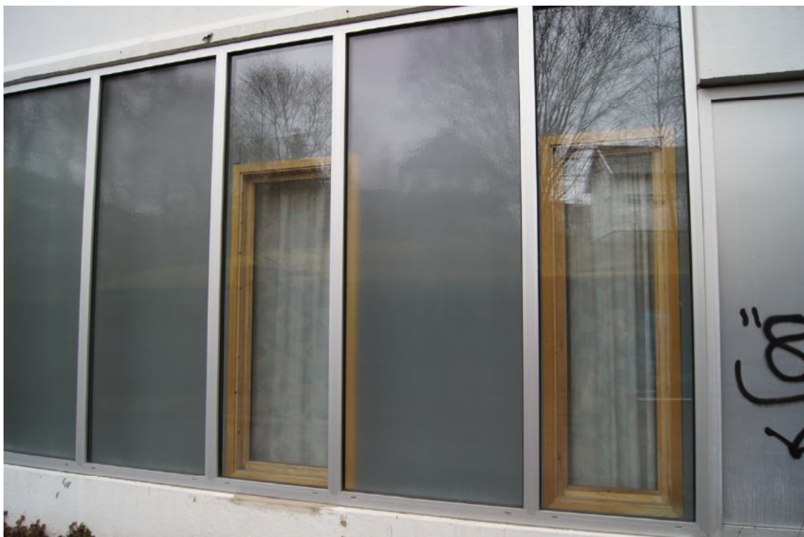
DETALJ FRÅ FASADEN MOT SØR, MED NYARE GLASFLATER OG INNVENDIGE VINDAUGE.
