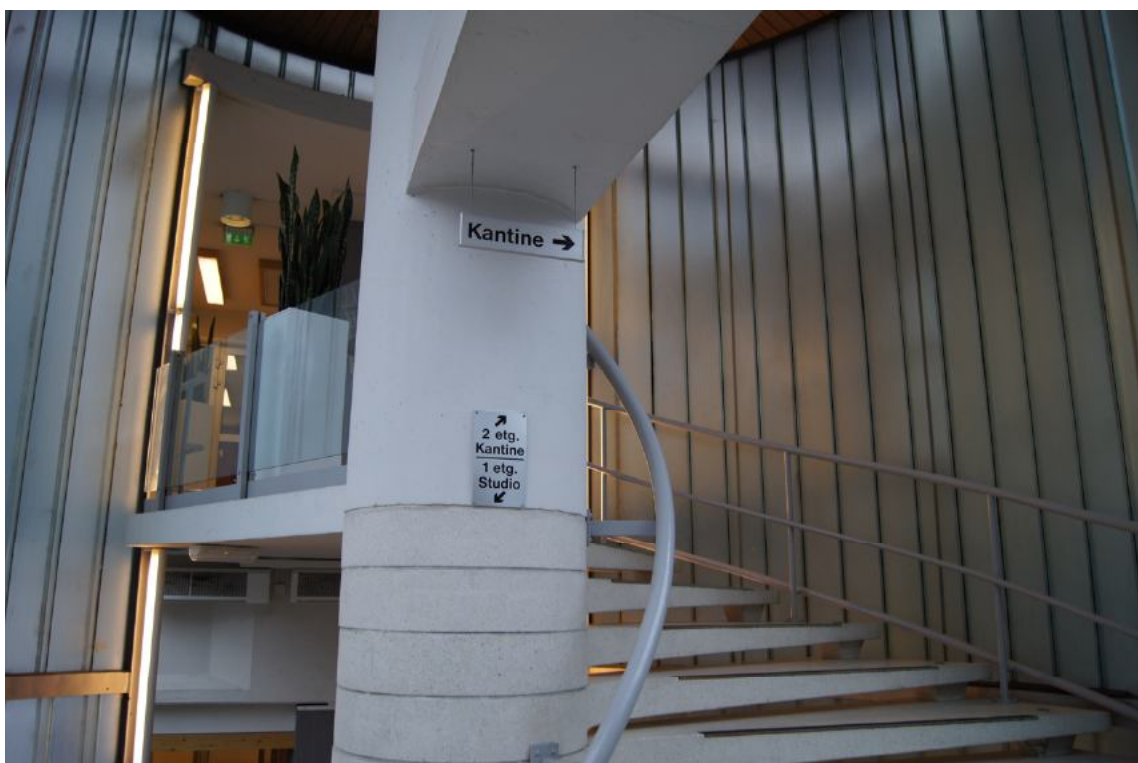
SJØLVE TRAPPEKONSTRUKSJONEN, DER TRINNA ER KRAGA UT AV MIDTSØYLA, ER BEVART.
