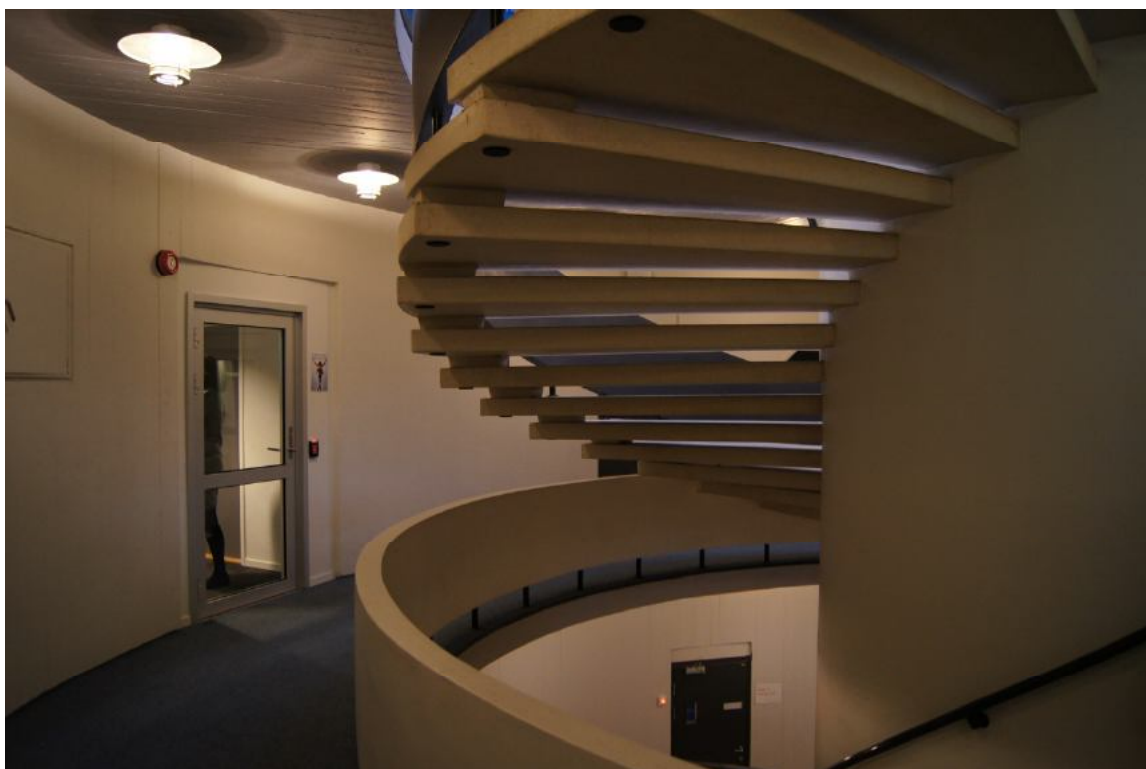
FRÅ TRAPPEROMMET I ANDRE ETASJE. DEN OPPHAVLEGE DØROPNINGA ER SYNLEG RUNDT NOVERANDE DØR.
