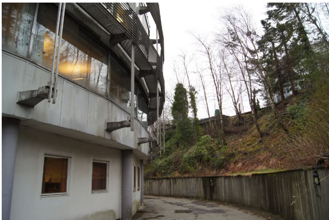
DELER AV FASADE OG MUR PÅ SØRSIDA AV BYGGET, SETT MOT AUST.
