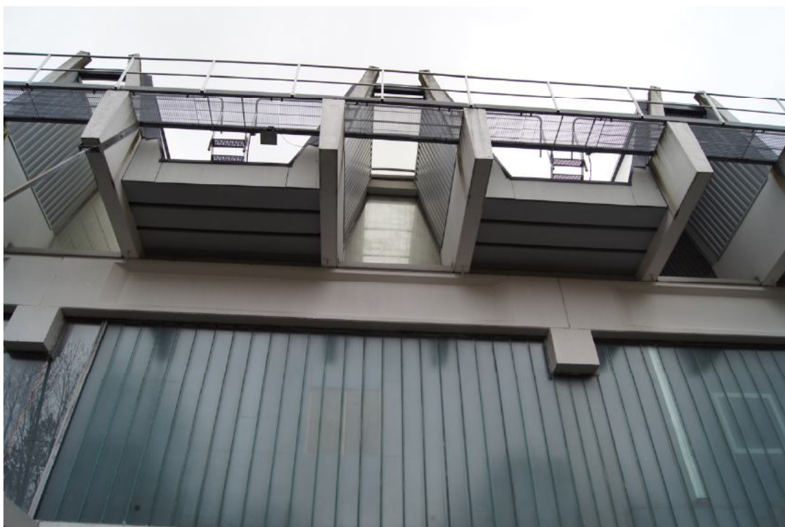
DETALJ FRÅ FASADEN MOT SØR, MED ORIGINALT GLASPANEL – PROFILIT – OG DEI NO KLEDDE V-FORMA TAKELEMENTA MED GANGBRU.
