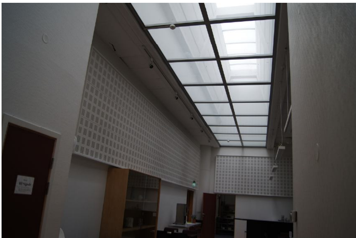
KAFEEN I KRISTKIRKENS LOKAL FÅR FRAMLEIS OVERLYS SOM ORIGINALT, I GLIPA MELLOM DEI V-FORMA TAKELEMENTA.
