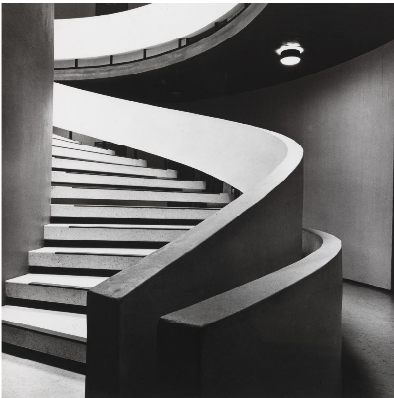
DETALJ FRÅ INNVEDIG TRAPPELØP I ADMINISTRASJONSBYGGET FRÅ FØRSTE TIL ANDRE ETASJE, HEISSJAKT TIL VENSTRE. UDATERT, ANTAKELIG 1966. FOR SAMANLIKNING MED DAGENS SITUASJON SJÅ BILDE SIDE 40. FOTO: BJØRN WINSNES/STIFTELSEN ARKITEKTURMUSEET (REPRODUKSJON AV NASJONALMUSEET/DAG ANDRE IVARSØY).
