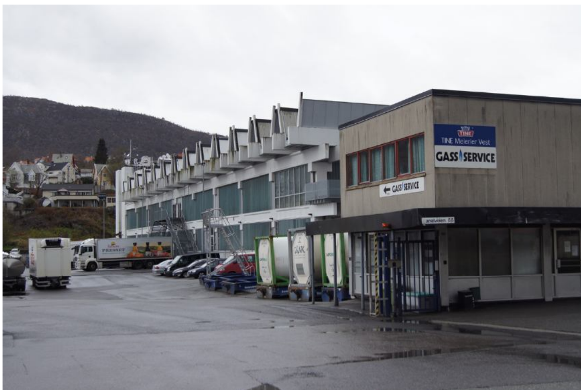
FASADE MOT NORD. PRODUKSJONSHALLEN I BAKGRUNNEN.
