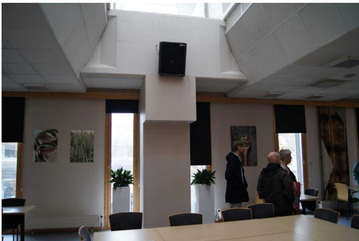
GLIMT AV KONSTRUKTIVE ELEMENT I NRK-KANTINA I ANDRE ETASJE, BETONGSØYLE OG DRAGAR MALT I KVITT OG DELVIS BYGD INN.
