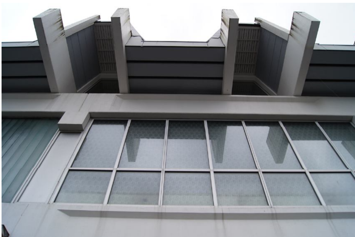
DETALJ FRÅ FASADEN MOT NORD, DER DET ORIGINALE GLASPANELET ER BYTA UT MED MØNSTRA VINDAUGSFLATER.
