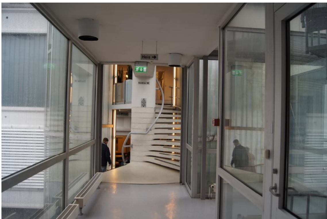
KORRIDOREN MELLOM ADMINISTRASJONSBYGGET OG TRAPPEHUSET MED TILGANG TIL HEIS TIL HØGRE.
