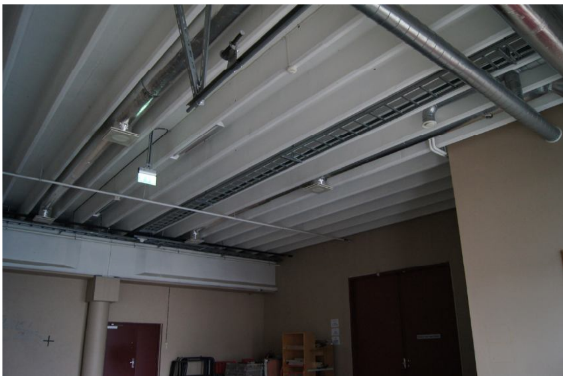
SYNLEGE BETONGELEMENT I TAKET I REKVISITALAGER.
