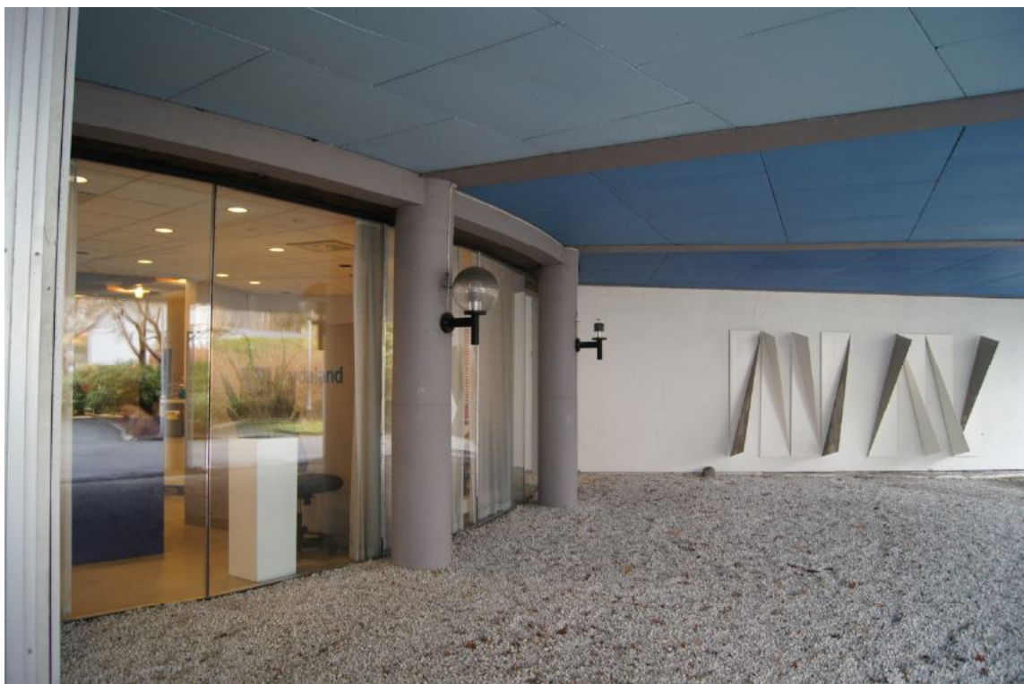
DETALJ INNGANGSPARTI. DENNE DELEN AV BYGGET HUSA ORIGINALT KONDITORIET, SJÅ BILDE SIDE 12.
