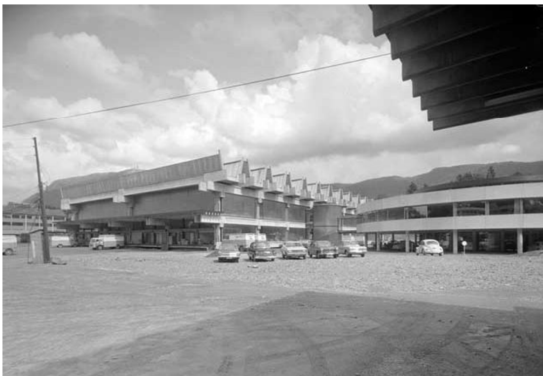
PRODUKSJONSHALLEN OG ADMINISTRASJONSBYGGET SETT FRÅ SØRVEST (PORTBYGGET), 3. JULI 1967. FOR SAMANLIKNING MED DAGENS SITUASJON SJÅ SIDE 21. FOTO: NORVIN REKLAMEFOTO/UBB BILLEDSAMLINGEN.
