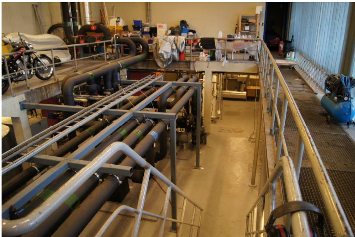
TRAPP NED TIL UNDERETASJE – FYRROM NEDRE DEL.
