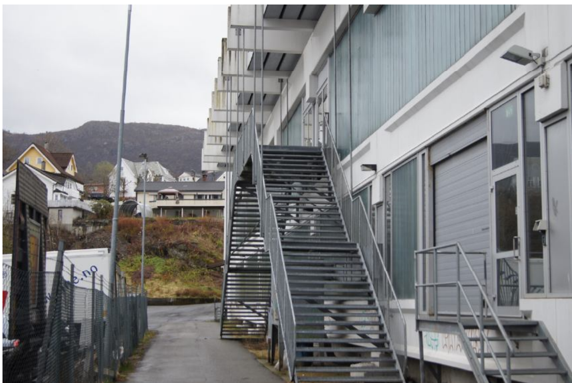
DETALJ FRÅ FASADEN MOT NORD, MED RØMNINGSVEG, PORT OG TRAPPER AV NYARE DATO.
