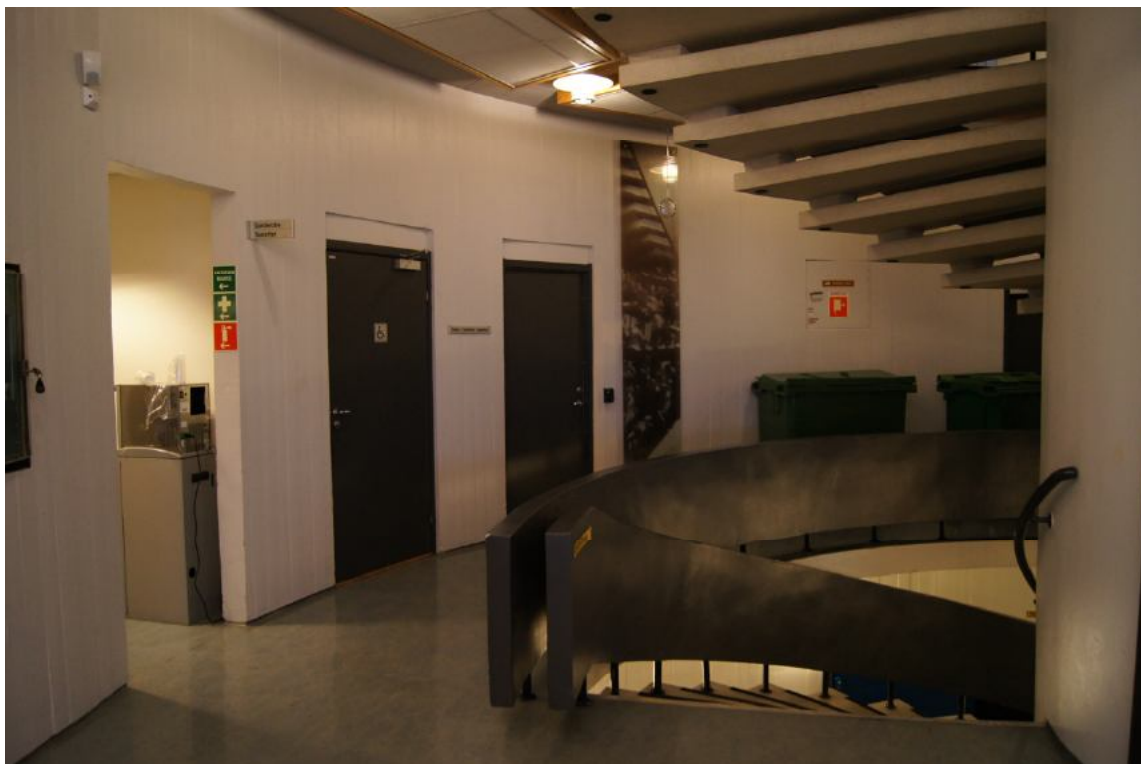
DEI OPPHAVLEGE DØROPNINGANE KAN SKIMTAST OVER DAGENS DØRER I TRAPPEROMMET I FØRSTE ETASJE. VEGGANE AV BETONG ER MALT KVITE OG DET ER LAGT GOLVBELEGG.
