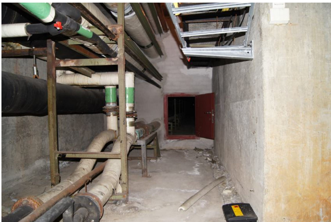
INNGANG TIL BLINDKJELLAR UNDER PRODUKSJONSHALLEN.
