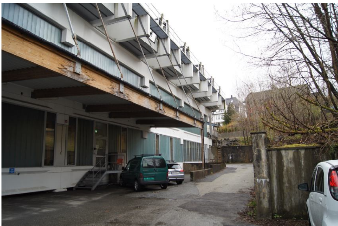
SØRSIDA AV BYGGET SETT MOT AUST, MED TAKUTSPRING, UTGANG OG VINDAUGE AV NYARE DATO.
