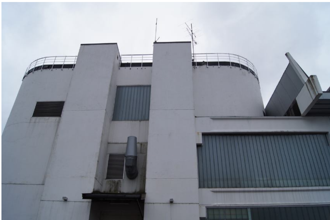
DETALJ FASADEN MOT AUST MED SYNLEGE OPPHAVLEGE HEIS- OG TRAPPESJAKTER.
