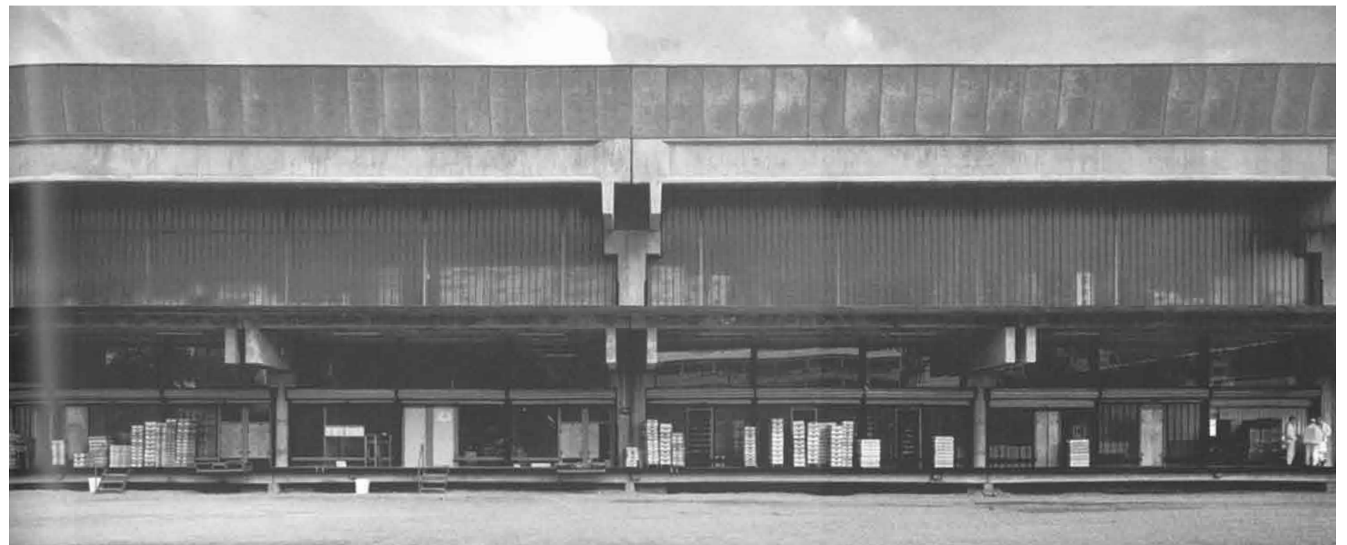
Fasade mot vest med opprinnelig ubehandlede betongkonstruksjoner; profilit-glass i andre etasje og klart glass med porter og dører i første etasje.
