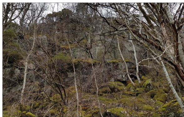
Fig. 12. Fjellhammer med sprangsteinblokker
