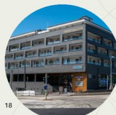
8 Lukket og avvisende fasade
