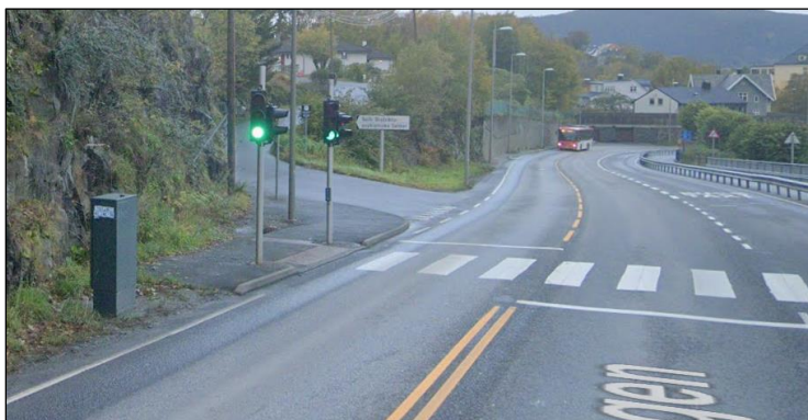
Figur 53: Eksisterende situasjon. Avkjørsel og fotgjengerfelt over Osvegen.
