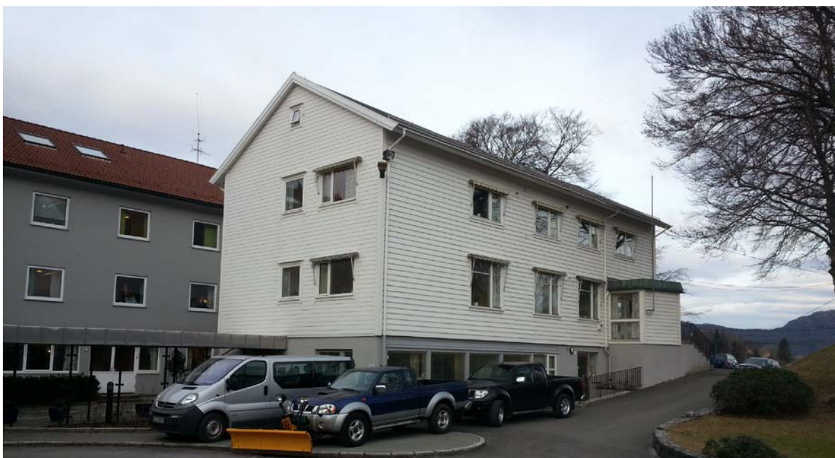
Figur 6: Solli DPS. 155 bygget til høyre sammenbygd med 1962 bygget til høyre.
