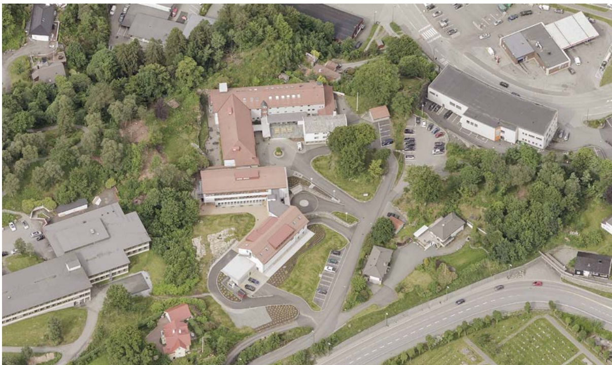
Figur 9: Solli DPS. Flyfoto sett fra øst.1962-bygget til høyre, 1974-bygget til venstre.
