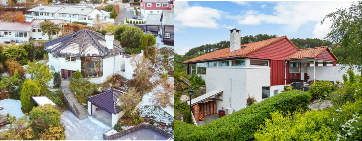
Figur 14. Venstre: Tolvkantet enebolig tegnet av Victor Ogann på Nordås. Bilde: Proaktiv Eiendomsmegling. Høyre: Enebolig tegnet av Victor Ogann på Tertnes. Bilde: Krogsveen. Begge boligene er tilpasset terrenget.
