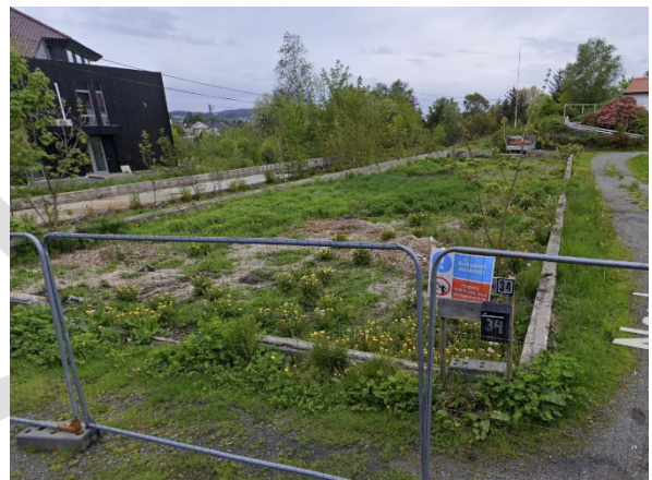
Figur 3-7 Grunnmur fra drivhus på gnr./bnr. 40/94.
