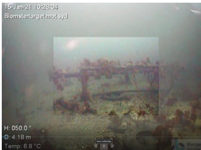
Figur 45 Kjølevannsinntaket til Mathallen ved Torget innerst i Vågen (Q2 i Figur 46).
