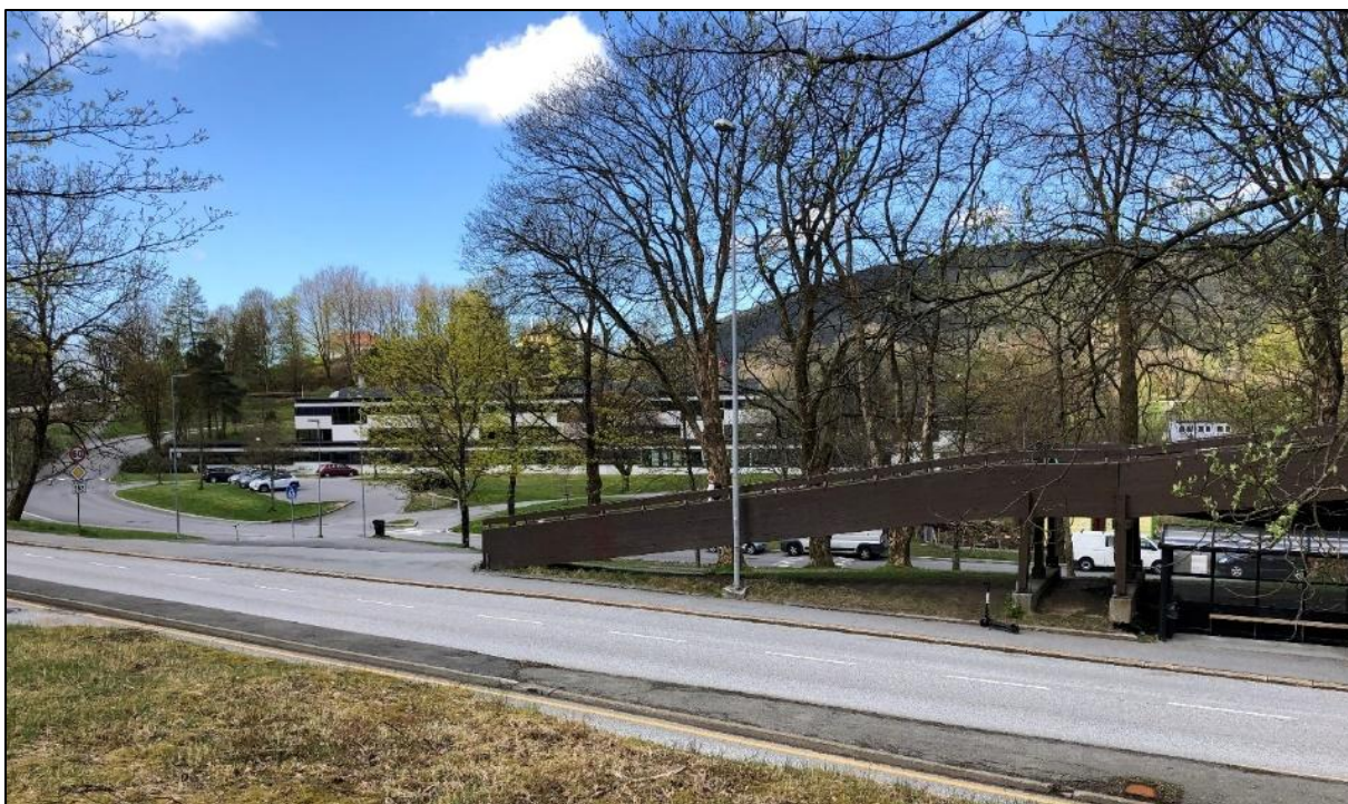
Figur 3.3.2 – Limtrebroen over Storetveitvegen. Skolen i bakgrunnen
