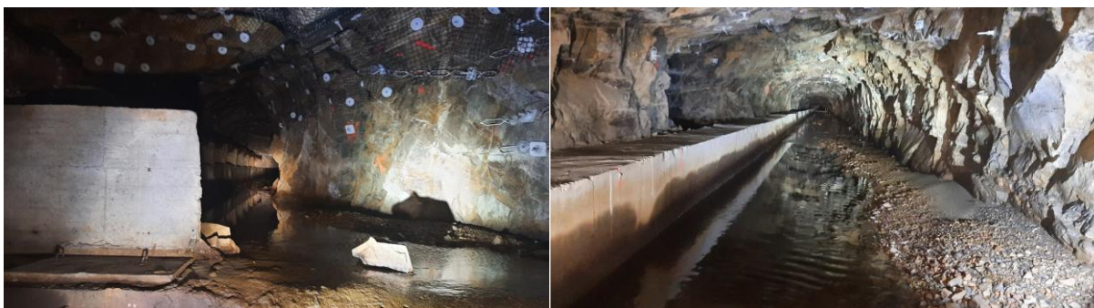
Figur 17: Bilder av kulverten som går under tiltaksområdet (foto: Bergen Vann).
