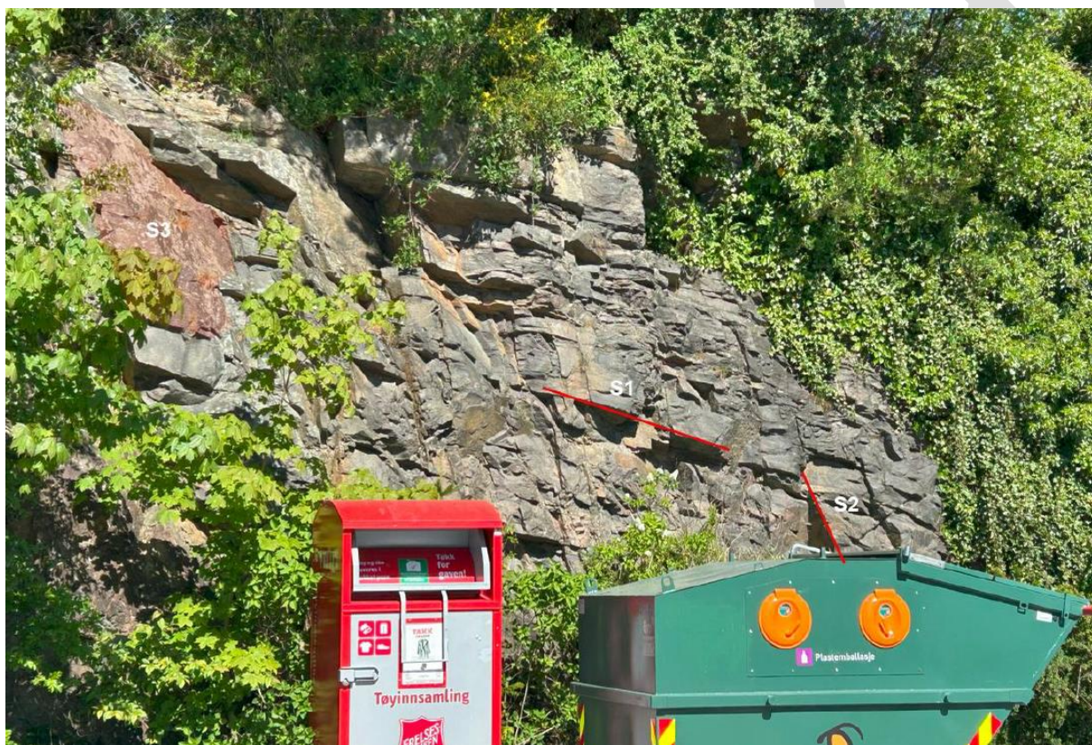
Figur 19: Faksimile fra Ingeniørgeologisk premissnotat for prosjektering utarbeidet av Multiconsult: Bergblotning sør på den aktuelle kollen som skal bebygges. Det er registrert tre sprekkesett i bergmassen rundt den aktuelle kollen (S1-S3). Terrenginngrep og eventuell sprengning kan medføre fare for overheng og blokkavløsning. Det vil derfor være behov for fjellsikringstiltak, som for eksempel bolting og montering av sikringsnett.
