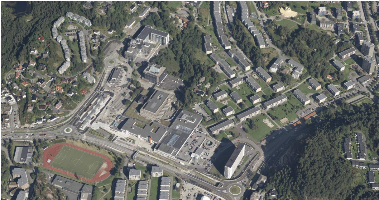
Figur 8: Flyfoto av Fyllingsdalen og området rundt Oasen kjøpesenter. Planområdet utgjør den skogkledde kollen med eneboliger i midten av bildet, som ligger rett nord for kjøpesenteret. Foto: 1881.no.
