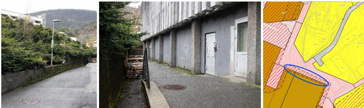
Figur 48: Dagens situasjon i passasjen mellom Nebbestølen (t.v.) og Oasen kjøpesenter (midten). Bildene ble tatt under befaring 08.11.2024. Utklipp av områdereguleringen (t.h.), passasjen er vist med blå ring.
