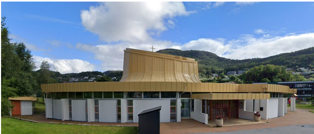
Figur 3-7. Fyllingsdalen kirke, 2022. Kilde: Google Maps.
