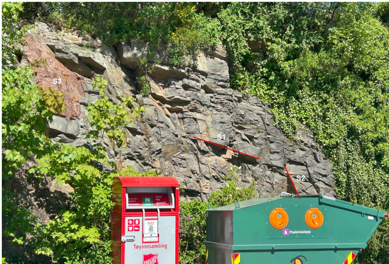
Figur 4. Bergblotning like sør for tiltaksområdet, med de registrerte sprekkesettene i bergmassen.
