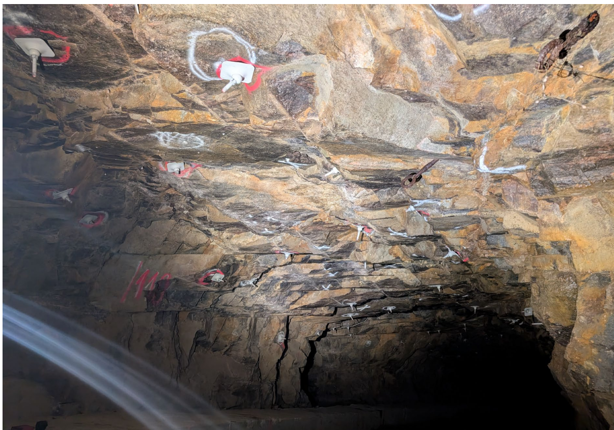
Figur 8 Det dominerende sprekkeplanet er nær horisontalt. Foto er tatt ved P110, som er rett ved knekkpunkt i vanntunnelen.
