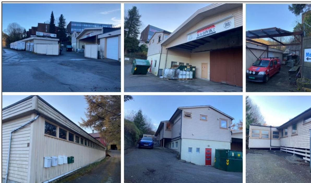
Figur 16: Bilder av bygget på gnr. 124, bnr. 356 (Kulturminnedokumentasjon datert 07.06.2024)
