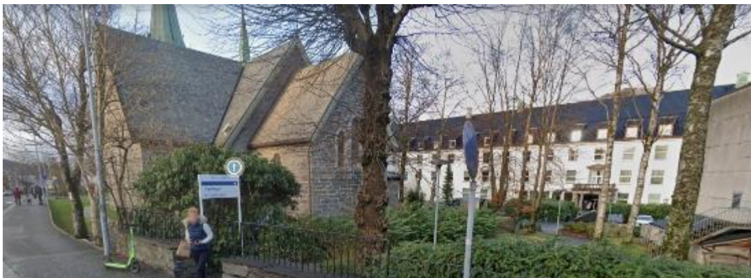
Figur 12 snarvei/gangtilkomst mellom kirken og Augebygget. Årstadhuset midt i bildet.
