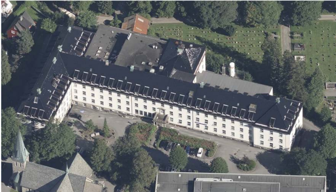
Figur 1: Skråfoto av Årstadhuset.
