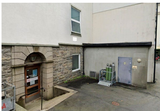
Dagens utgang mot nord og dør til teknisk rom Bilde fra google maps.
