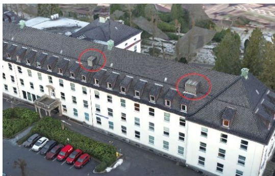
Eksisterende ventilasjonsinntak
